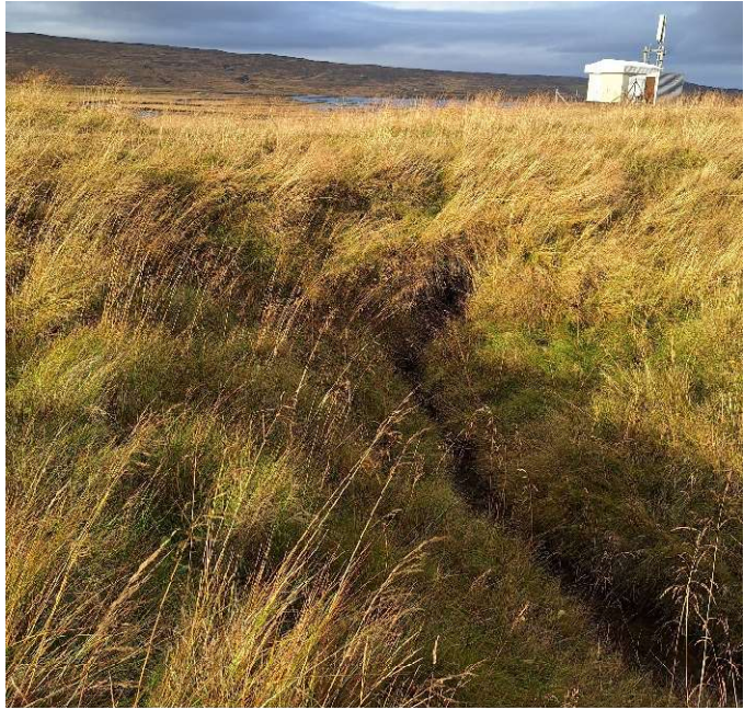
Mynd 5. Brú [3507-4], horft til VNV. Spennistöð í baksýn.
