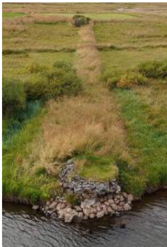
Mynd 245. Horft inn í hleðslu brúar [3356-238] til vesturs. Vegur [3356-239] liggur frá brúnni í landi Hamars.
