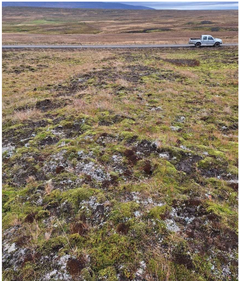
Mynd 26. Vegur [3487-21], horft til austurs.
