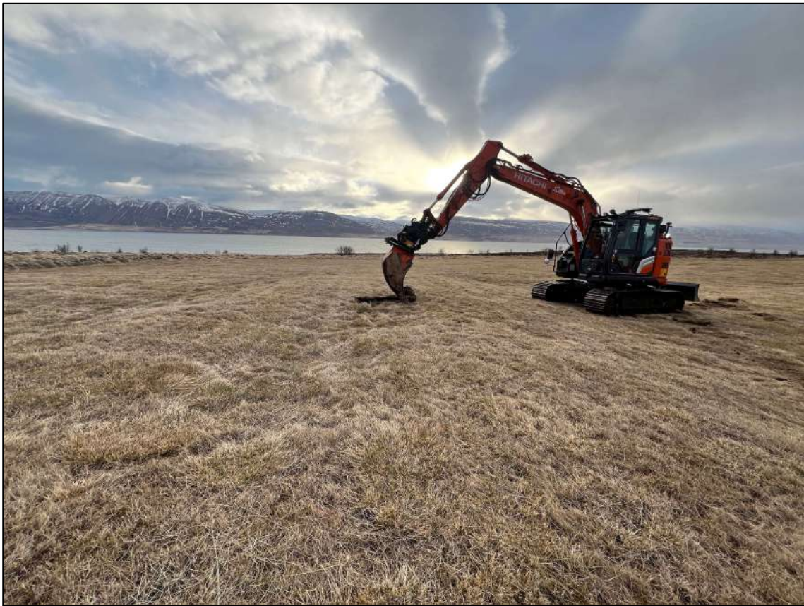
Ljósmynd 8 Horft til austurs eftir skálatóft við upphaf skurðargraftar.
