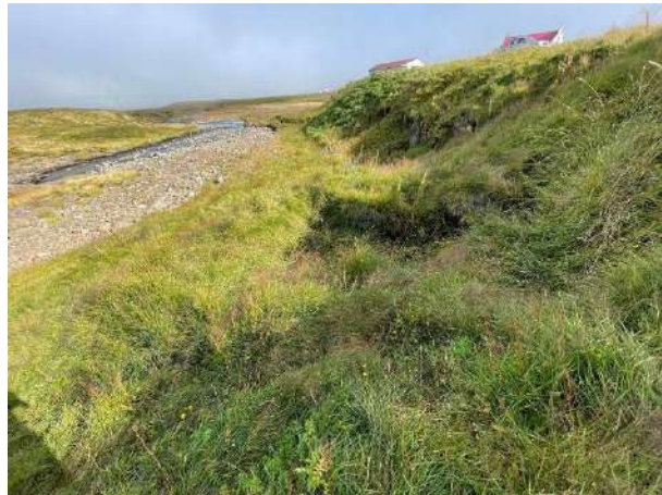
Mynd 164. Hleðsla [2867-253]. Horft til austurs.
