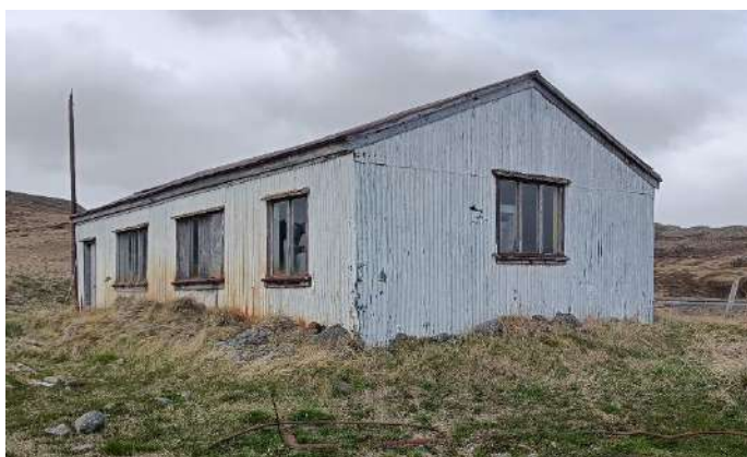
Mynd 156. Grjót sést neðst við húsveggina og er mögulega eitthvað af því úr eldri byggingum, horft til vesturs.
