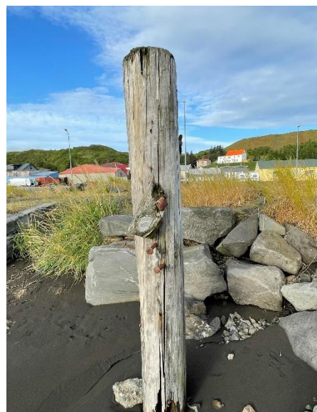
Mynd 17. Tréstaupur úr Gömlu bryggju - horft til vesturs.
