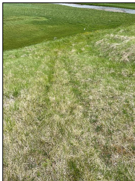
Mynd 71. 2696-108, horft til A.
