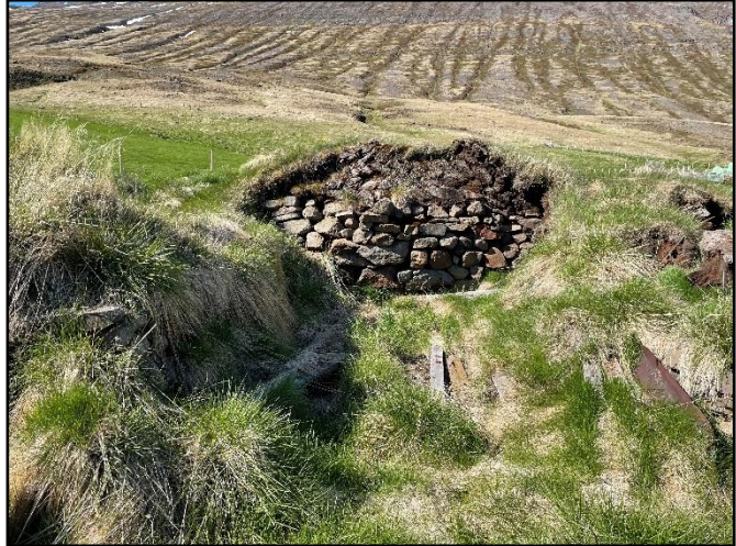
Mynd 2. 2696-2, horft til SV.
