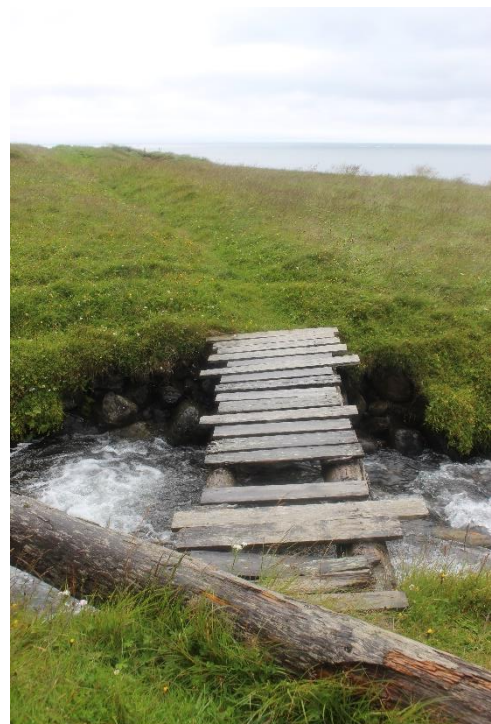
Mynd 9. Brú [2064--94] á bæjarlæknum, sést í hleðslur í austari lækjarbakkanum.
