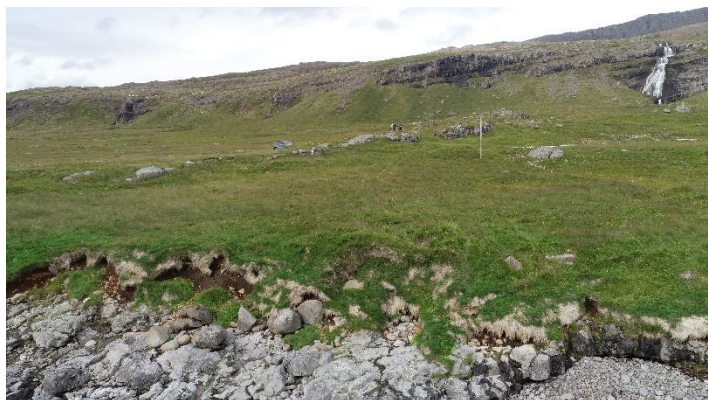
Mynd 11. Tóft íshúss [2064-103] á sjávarbakka sem er að hluta horfið.
