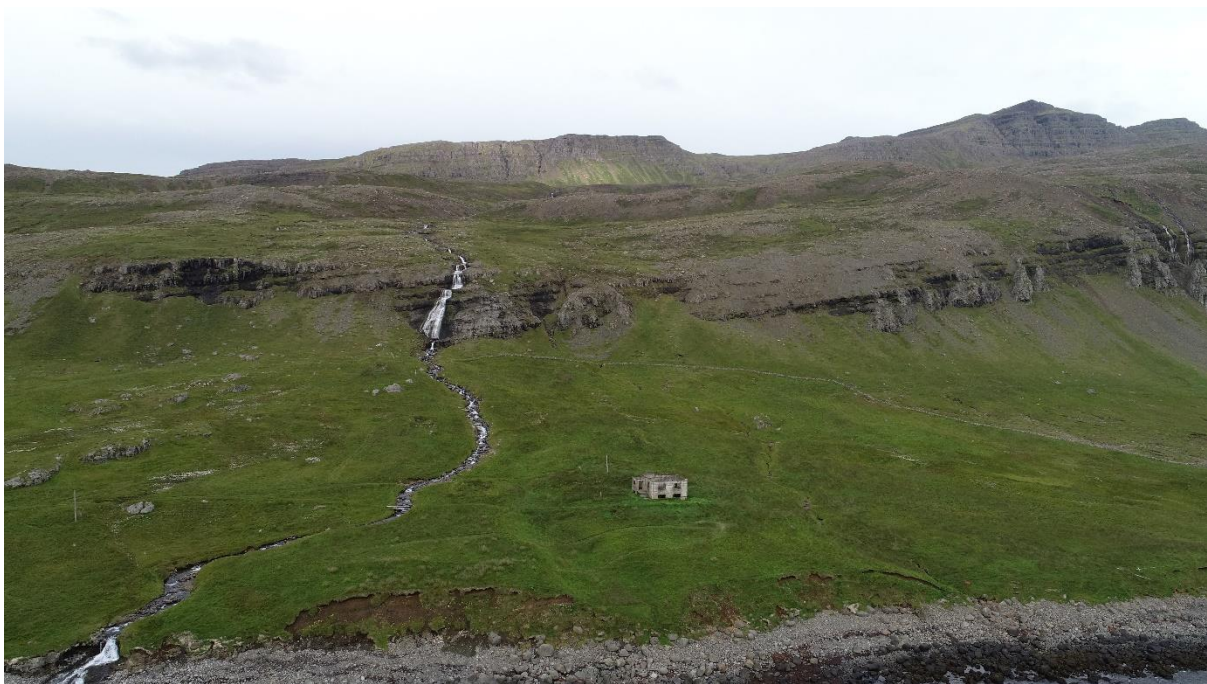
Mynd 1. Horft til norðurs yfir bæjarstæði Karlskála. Enn standa uppi veggir steinsteypst íbúðarhús sem brann 1961, bæjarhóllinn [2064-84] er bak húsinu. Eins og sjá má brýtur sjórinn af bökkum neðan bæjarstæðisins.
