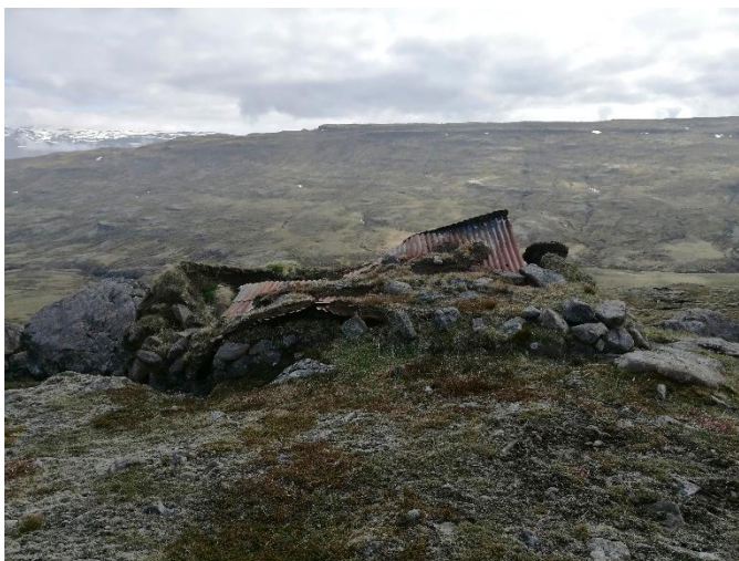
Mynd 5. Vesturhlið Geitdalskofa. Hér sjást grjóthlaðnar vegghleðslur sem nú eru að nokkru grónar og þakið sem er að mestu fallið ofan í tóftina. Horft er til austurs.
