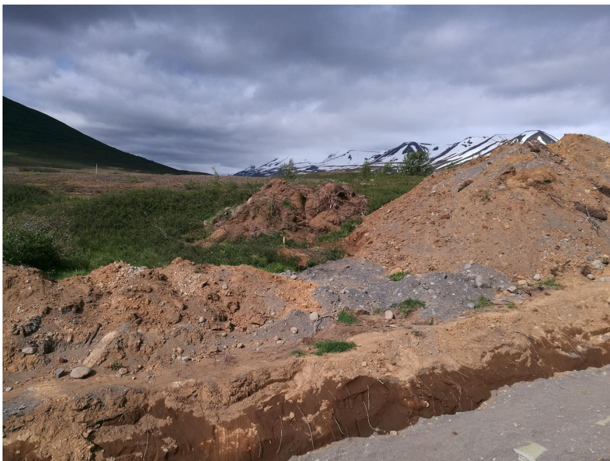
Mynd 2. Horft til norðausturs yfir framkvæmdasvæðið. Stika sem sjá má framan við moldarbing ofan við miðju myndar merkir legu kolagrafarinnar.
