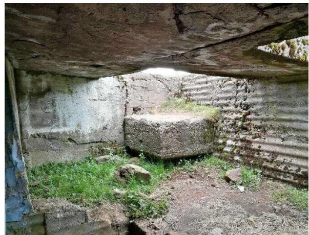
Mynd 23. Myndin er tekin ofan í byggingunni.
