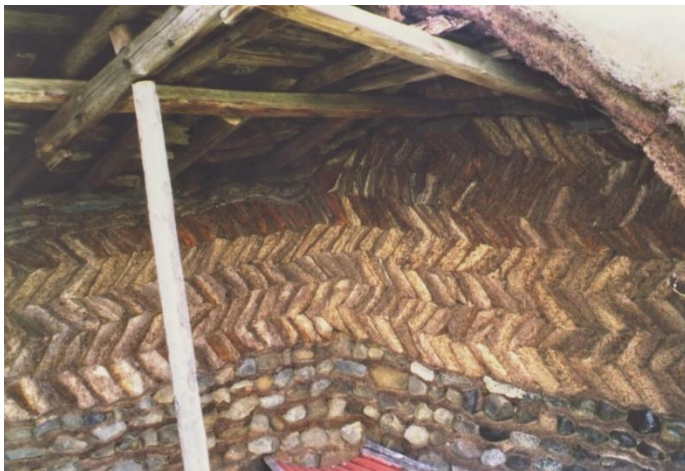
Mynd 17. Þegar lesið er úr myndum er fyrst skoðað hvers konar hleðslugerðir blasa við og hver eru helstu einkenni húsgrindanna, ef þær sjást. Á þessari mynd má telja sex grjótlög neðst í veggjum. Grjótið er lagt í streng til að stemma og styðja hleðsluna. Ofan við grjóthleðslur hefur verið hlaðið úr klömbruhnaus án strengbindingar. Klömbrurnar víxlleggjast alla leið upp þar til í annarri og þriðju röð ofan frá að þeir eru lagðir eins þannig að munstrið brotnar upp. Ofan á langveggi, undir rafta, eru lagðir strengir. Í klömbruhnausunum sjást margskonar litbrigði, s.s. af ljósum leir og mýrarrauða, sem ljáir torfinu, ljósa, gyllta og rauða tóna. Þaktorfið er fremur þunnt. Í mesta lagi samsett úr þremur torflögum. Tveir
