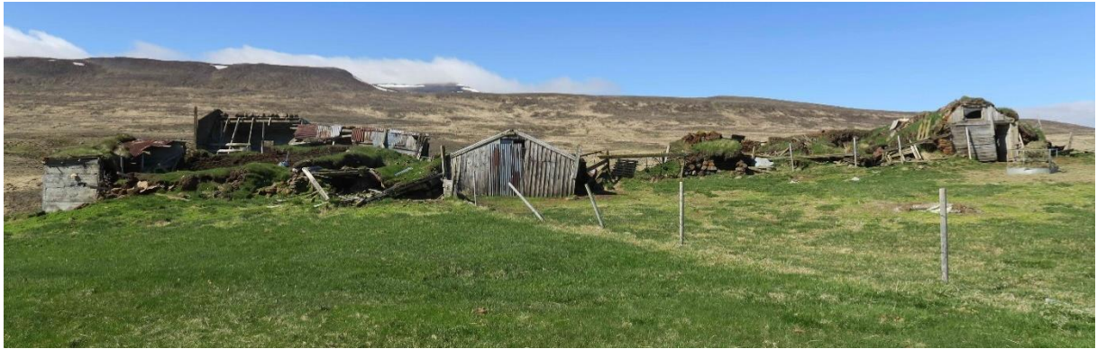
Mynd 81. Ofar. Búpeningshúsin voru meira og minna hlaðin úr grjóti og torfi/Ljósm.BZ-2018.
