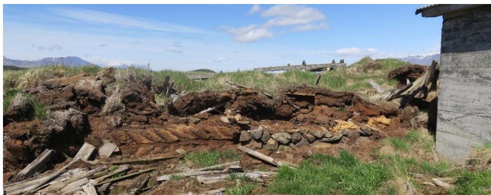
Mynd 77. Fjárhúsveggur. Til hægri er grjóthleðsla með streng á milli laga. Til vinstri er klambra lögð í streng. Efst er veggurinn hlaðinn úr streng/Ljósm. BZ-2018.
