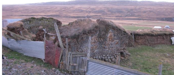
Mynd 148. Hlöðuveggir eru enn háir og stæðilegir. Undirstöður veggja eru grjóthlaðnar, með grjóti í streng. Mest ber á stórstungnum klömbruhnausum í hleðslunni/Ljósm.BZ-2010.
