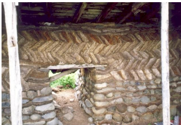
Mynd 123. Myndin sýnir tóftardyr milli hlöðu og fjárhúsa í Bakkakoti. Ríkjandi hleðslugerð í búpeningshúsunum þar var klömbruhleðsla í streng en í hlöðunni og í fjárhúsunum var hleðslan nánast strengjalaus, eins og sést á myndinni. Veggir voru hlaðnir upp í 1,2-1,5m hæð úr fremur smáu skriðugrjóti í streng og þar ofan á úr klömbruhnaus. Raftar lágu þversum yfir tóftardyrnar eins og í Guttabúi/Ljósm.SS-1992.
