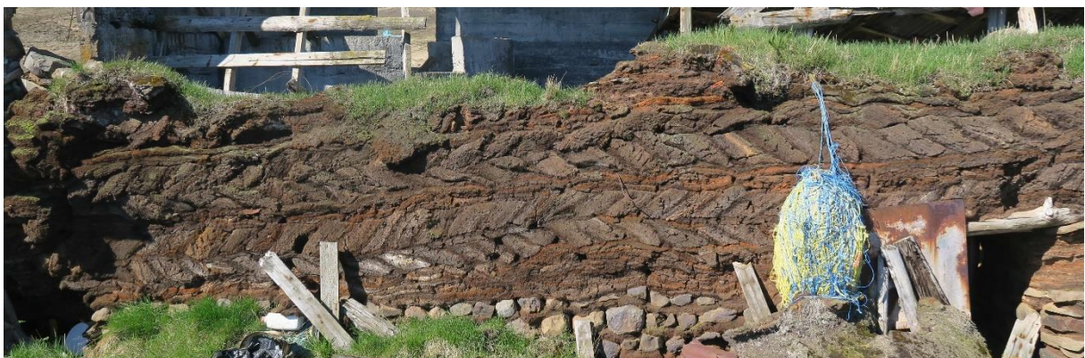
Mynd 85. Veggur á milli fjárhúsa og hlöðu. Rekaviður er lagður yfir tóftardyrnar. Veggghleðslur eru úr skriðugrjóti og streng í neðri hluta en klömbru og streng í efri hlutanum. Hér bregður fyrir fremur óalgengri hleðsluaðferð, þ.e. að leggja nokkur lög af streng á milli klömbruhausanna í annari hverri röð. Smágert língresið, eins og þarna óx á veggjabrotum og þökum er einkennisjurt í þurrum gömlum tünnum. Það þolir langvarandi þurrka betur en flestar plöntur. Sé það komið í þök þarf ekki að hafa áhyggjur af vökvun. Hið sama gildir um húsapuntinn/Ljósm.BZ-2018.
