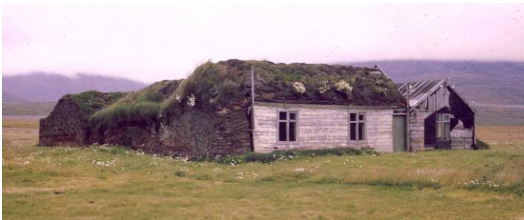
Mynd 162. Framhúsið er næst á myndinni, þá er baðstofa með geymslu í endanum fjær og aftast, til vinstri, er hesthús-gafl. Hægra megin við framhúsið er stofa. Gaflar hússins voru ýmist eingöngu hlaðnir úr streng eða úr klömbruhnaus í streng. Í veggjum íbúðarhúsanna var aðeins grjót í undirstöðum/Ljósm. Einkaeign-1975.
