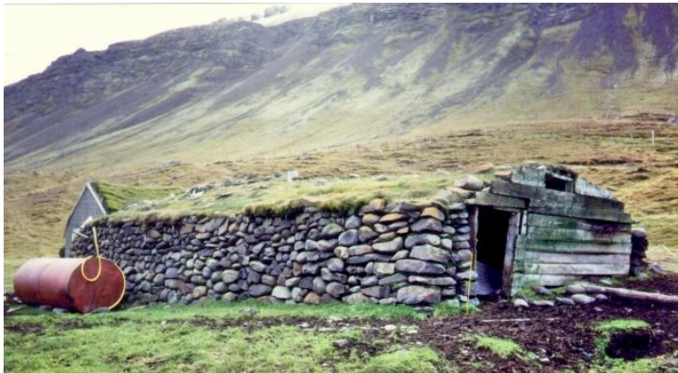
Mynd 127. Austurveggur sömu fjárhúsa. Eins og vel má sjá var strengurinn, sem grjótið var lagt í, nær alveg burtu veðrað á útveggjum húsanna. Veggirnir voru vel hlaðnir úr náttúrlegu ótilhöggnu skriðugrjóti og bundnir með streng/Ljósm.SS-1990.
