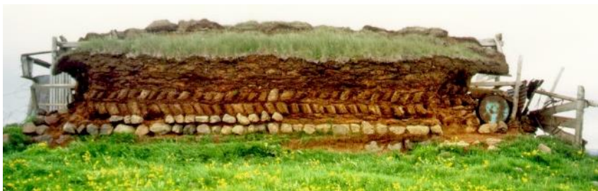
Mynd 88. Í hluta norðurveggjar, sem var orðinn mjög slitinn, sást í fyllinguna á milli innri og ytri hliðar veggjarins. Sporðar klömbruhnausanna liggja inn í vegginn og á milli þeirra er fylling úr afskurði, roftorfi og öðrum rætnum jarðvegi. Í fyllingunni sást að torfbinding var þvert yfir uppfyllinguna á milli ytri og innri hliðar (ytra og innra borð) veggjarins. Veggþykktin var um 1,2 m. Klömbruhnausarnir voru um 40sm langir þannig að uppfyllingarefnið var drjúgt/Ljósm.ABB-1999.
