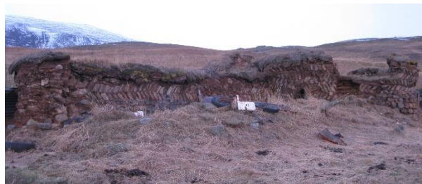
Mynd 147. Stórhús eru vel upp hlaðin úr klömbruhnaus og streng/Ljósm.BZ-2010.
