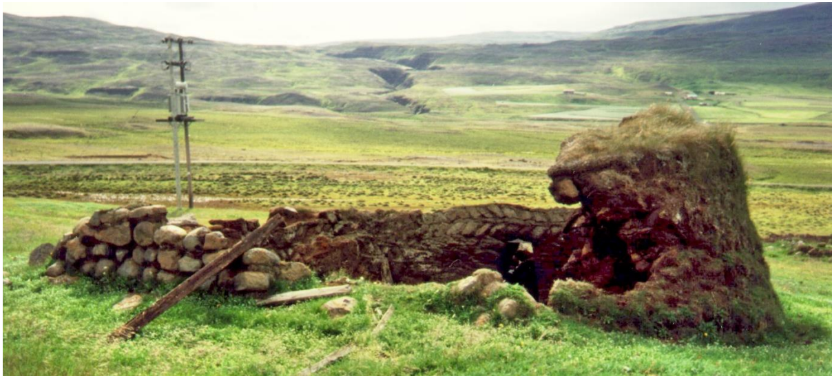
Mynd 109. Hlaðan stóð stök um 10 metrum austan við fjárhúsin. Bæði hlaðan og húsin voru hlaðin úr klömbruhnaus með streng á milli. Hlöðuveggir voru allir út torfi nema austurveggurinn sem var hlaðinn úr grjóti og streng/Ljósm.SS-1992.
