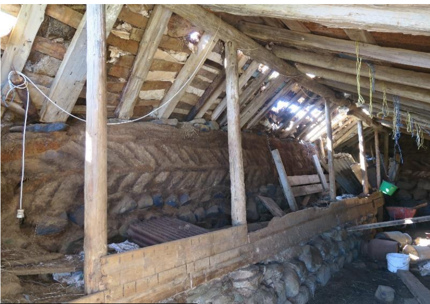
Mynd 83. Veggir hesthússins voru hlaðnir upp til háls úr skriðugrjóti í streng og upp úr með klömbruhnaus í streng. Grjóthlaðinn stallur var við annan langvegginn. Garðastokkar voru negldir á stoðir undir mænisásum, sem stóðu á garðanum. Þetta var einásahús. Raftar lágu á á ásin beint veggjum. Veggmegin, undir endum raftanna, voru hellublöð. Nokkur lög af streng voru efst í veggheðslunni. Í árefti voru notaðir tunnustafir og allskonar afgangs trjáviður/Ljósm.BZ-2018.
