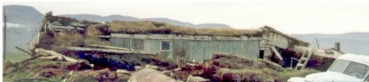
Mynd 60. Horft vestur yfir tóftarleifar húsanna. Framhluti bæjarins var lengi notaður sem geymsla /Ljósm.SS-1988.
