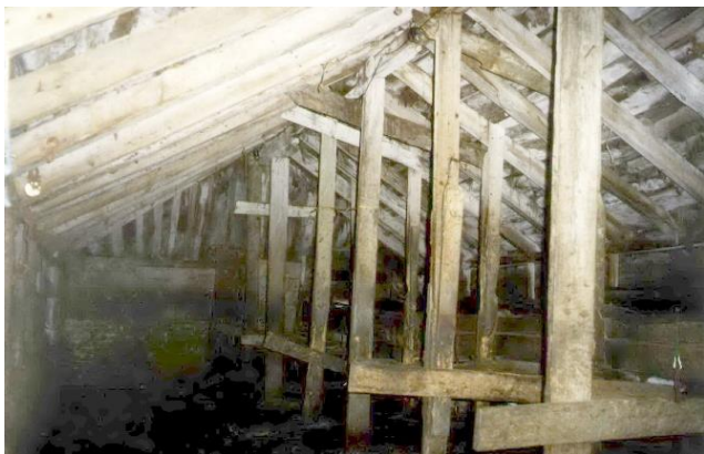
Mynd 171. Í fjósinu (hesthúsinu), sem var einása hús, voru stoðir undir mænisás og undir lausholtum (syllum). Tréborð voru negld á milli þeirra, frá útstoðum á innstoðir, til að afmarka básana. Stallurinn var tréstokkur úr timbri og náði allan langvegginn. Undir honum vottaði fyrir grjótröð sem gæti hafa verið frambrún jötu á fjóstíma hússins /Ljósm.SS-1999.
