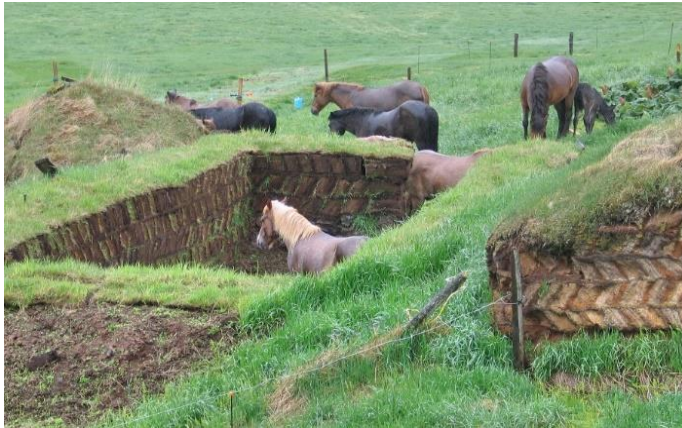
Mynd 16. Réttarveggir urðu að vera það háir að þeir væru fjárheldir, ekki lægri en 1,5-2m á hæð. Búfenaður vippar sér auðveldlega yfir lægri vegg. Efst í réttarveggjum og á þökum var notast við grundartorf eða valllendistorf sem rist var með undirristuspaða á þurru rötargóðu landi. Uppgrónar og fallnar hleðslur, sem hlaðnar voru eingöngu úr torfi eða grjóti í torf, eru oft illgreinanlegar hafi þær riðlast til, hjaðnað til jarðar og gróið upp/Ljósm.BZ-2011.
