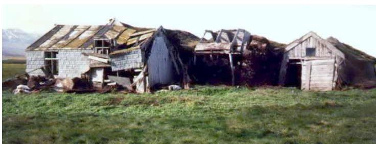
Mynd 163. Sunnan við framhúsið var blikklædd stofa. Hægra megin var hana var búr og við hliðina á því lengst t.h. var hesthús. Veggirnir, bæði milliveggir og austurveggur hesthússins, voru hlaðnir úr klömbruhnaus í streng og tvö neðstu lögin voru úr grjóti í streng, eins og að norðanverðu/Ljósm.SS-1988.
