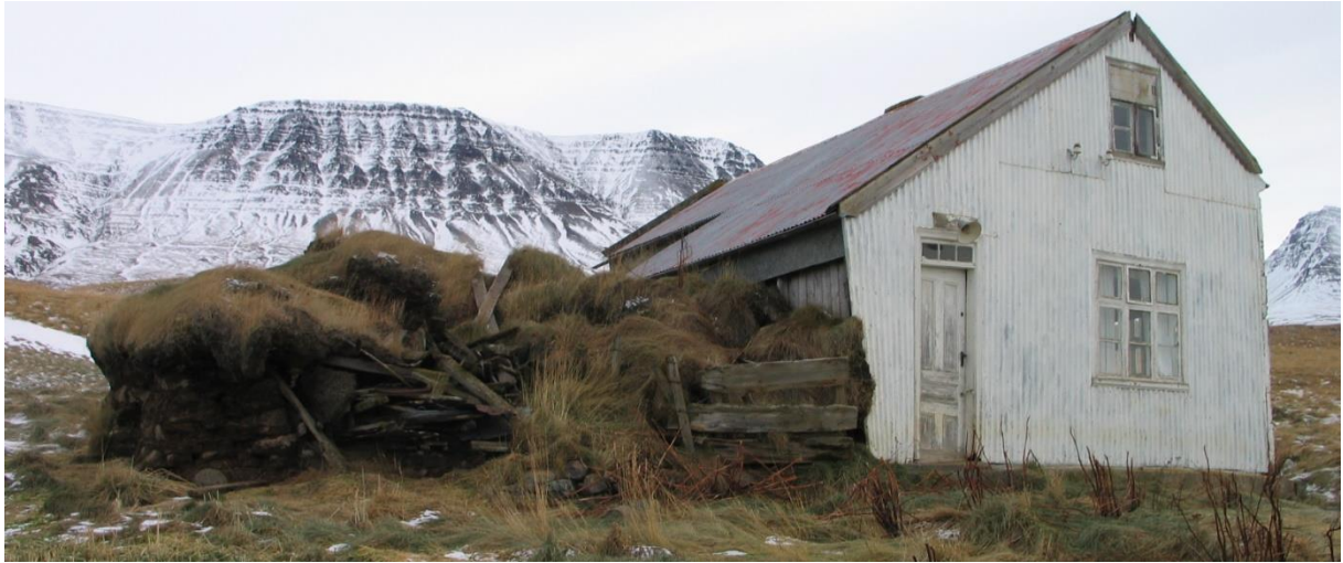
Mynd 156. Árið 2006 var enn vel hægt að sjá hleðslur í leifum gamla torfbæjarins. Lengst t.v. var hlóðaeldhúsið, þá fjós og skemmuskot næst hússinu. Reynt var að verja torfhleðslur í skemmuveggnum upp við húsið, fyrir hrúni, með timburpili/Ljósm.SS-2006.
