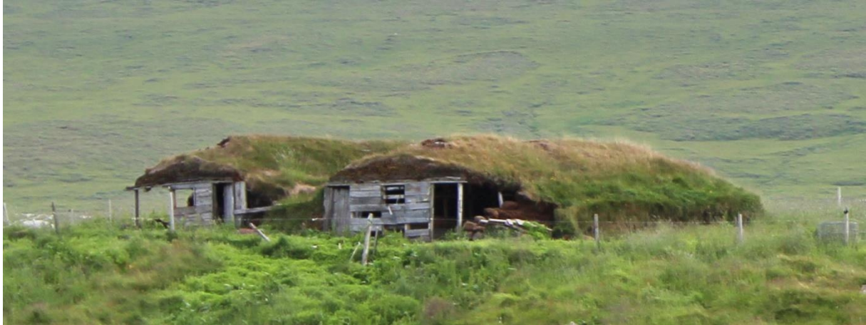
Mynd 89. Fjárhúsin eru tvöföld, tvístæð, garðahús, þ.e. garði er eftir miðju húsi í þeim báðum, tvær krær (fjórar samtals). Húsin eru nú með timburgöflum. Grjóti er hlaðið í streng neðst í veggjum upp undir miðja vegg en að öðru leyti eru þeir hlaðnir úr klömbruhnaus í streng eða eingöngu úr streng/Ljósm.SS-2017.
