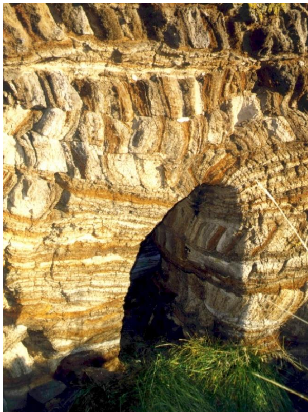
Mynd 147. Stórhús eru vel upp hlaðin úr klömbruhnaus og streng/Ljósm.BZ-2010.
