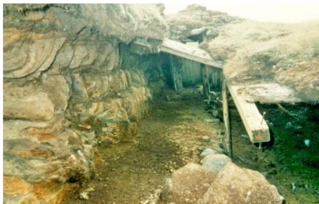
Mynd 112. Sama fyrirkomulag var í suðurhúsinu. Þakraftar lágu á hellublöðum á suðurveggnum, eins og í hinu húsinu. Grjótröð (grjótkantur) afmarkaði jötubreiddina. Jötustokkur var settur ofan á hana. Krær húsanna voru mjóar, rétt um tveir metrar á breidd. Stoðir stóðu á stoðarsteinum undir „langröftum“ sem náðu frá mænisás út á syðri vegginn. Á þær, á milli krónna, hafði verið neglt timburþil/Ljósm.SS-1989.
