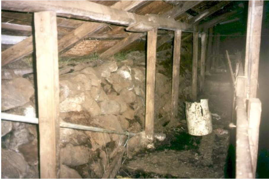
Mynd 73. Hér er horft jötumegin inn eftir Naut-húsi. Á innri hlið suður-veggjarins var hlaðið úr grjóti í streng alveg upp úr. Á stöku stað var hlaðið úr streng ofan á grjóthleðslur. Grjótið var fremur stórgert skriðu-grjót. Þakraftar voru lagðir beint á vegg og fremur langt inn á þá þannig að skot myndaðist milli þaks og veggja. Veggjastoðir (útstoðir) stóðu undir syllum (laus-holtum) en raftaendar lágu á veggslægu/Ljósm. ABB-1999.
