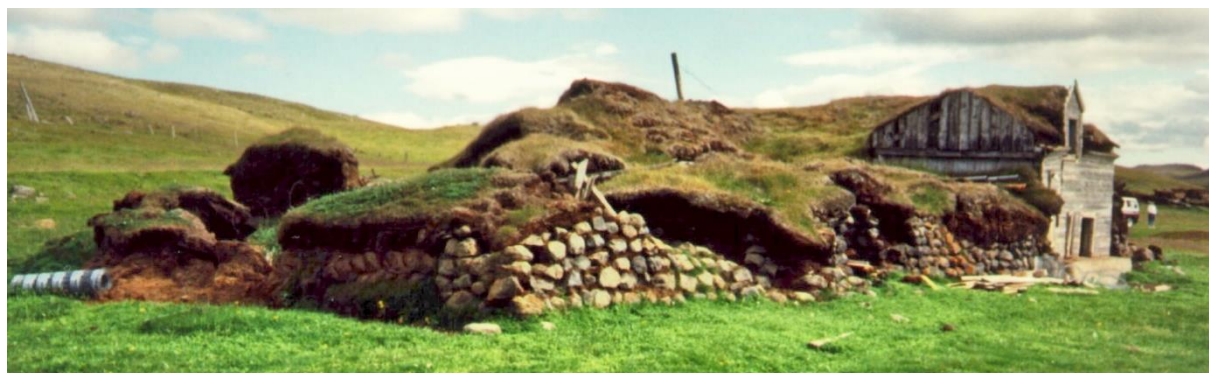
Mynd 101. Næst á myndinni er hesthúsið og þarnaest fjósið, norðan við bæjardyrnar. Veggir búpeningshúsa voru meira og minna hlaðnir úr grjóti (skriðugrjóti) í torf (streng). Hlöðuveggir voru meira úr torfi en grjóti einkum önnur langhliðin. Ríkjandi torfhleðslur voru klömbruhnausar í streng /Ljósm.SS-1989.
