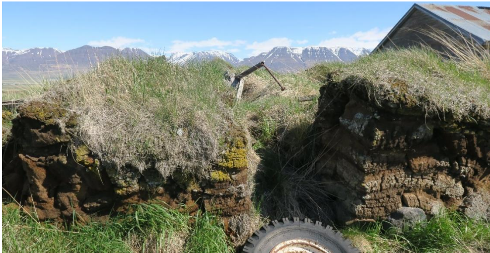
Mynd 76. Dyr á milli hlöðu og fjárhúsa. Hér eru hornhnausar með streng á milli laga. Grjót er neðst í veggjum. Á veggjabrotum þessum bar meira á húsa-punti en smágerða língresinu sem einkenndi flest gömul þök og tóftarbrot/Ljósm. BZ-2018.
