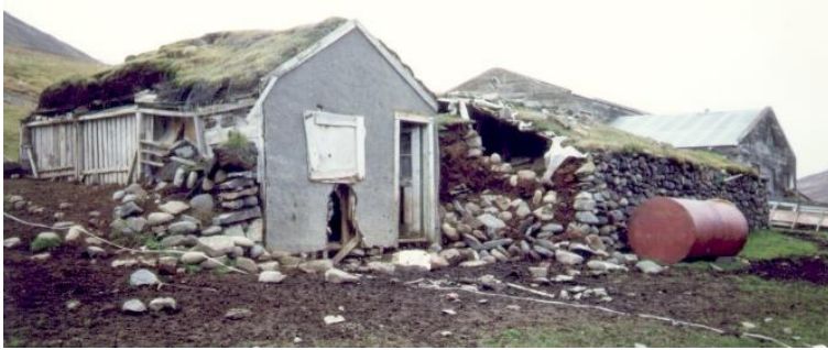
Mynd 126. Fjárhús stóðu um 30m vestan við íbúðarhúsið frá 1947. Nær á mynd er skemma. Þessi húsin voru byggð upp af grunni gamla torfbæjarins. Fjærst er steinsteypt fjárhús. Veggir húsanna, voru hlaðnir úr skriðugrjóti í streng. Torfið var svo veðrað á ytri hlið veggjanna að það sást aðeins í það á stöku stað/Ljósm.SS-1990.
