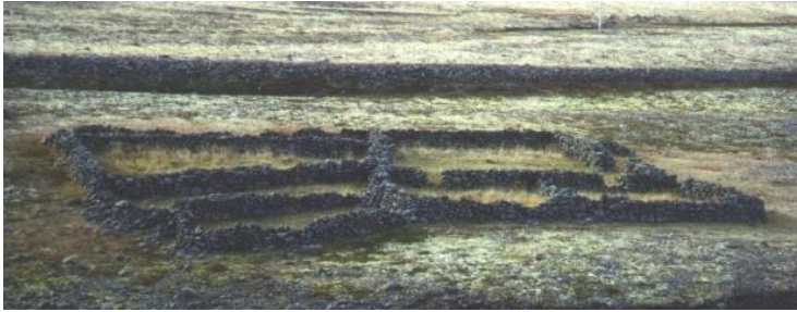
Mynd 116. Hofsrett er ferhyrnd að lögun og virðist hafa verið hlaðin upp eftir þörfum og fjárfjölda. Hún var notuð fyrir Hofsbæina fram yfir miðja 20. öld. Grjótið í hana var týnt upp af eyrunum í kring og réttin hlaðin úr þurru grjótinu/Ljósm.SS-2003 og Loftmyndir ehf. 74
