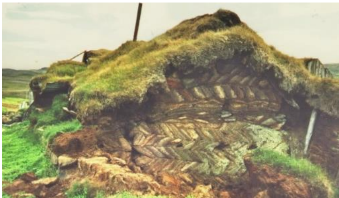
Mynd 104. Torfhleðslur í gafilhlaði fjóshlöðunnar, norðan við bæinn, voru margskonar. Neðst í veggnum var klömbruhleðsla án strengbindingar. Ofan á henni var strengjahleðsla, sem hefur verið efsta lag gafilhlaðsins áður en það var hækkað upp. Uppgildingin þar ofan á var úr klömbruhnaus með streng í milli. Skorið hefur verið sæti fyrir mænisásenda sem hefur verið lagður á steinhellur efst á gafilhlaðinu. Þær voru enn á sínum stað í miðju gafilhlaðinu. Stoðarsteinar voru enn á miðju gólfi/Ljósm.SS-1992.
