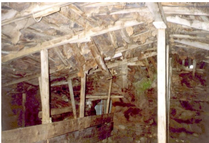
Mynd 18 er tekin í hesthúsi, sem áður var fjós, einnig í Bakkakoti. Þetta var einásahús, með röftum sem lagðir voru frá lausholtum (syllum) yfir á mænisásinn. Allbreitt bil var á milli raftanna og áreftið, sem lagt var þvert á þá, var byrjað að missa „tökin“. Nærtorfið, neðsta torflag þaksins, fylgdi á eftir áreftinu og lafði víða niður á milli. Undir ásum stóðu stoðir nokkuð þétt og mörkuðu básabreiddina og veggstoðir stóðu undir lausholtum (syllum). 11 Búið var að smíða stall við annan langvegginn í stað jötu. Neðstu hleðslulög húsveggjanna voru úr grjóti sem hlaðið var í torf upp í um 40sm hæð. Ofan á var hlaðið úr klömbruhnaus í streng upp um þrjú lög og efst í veggjum var
