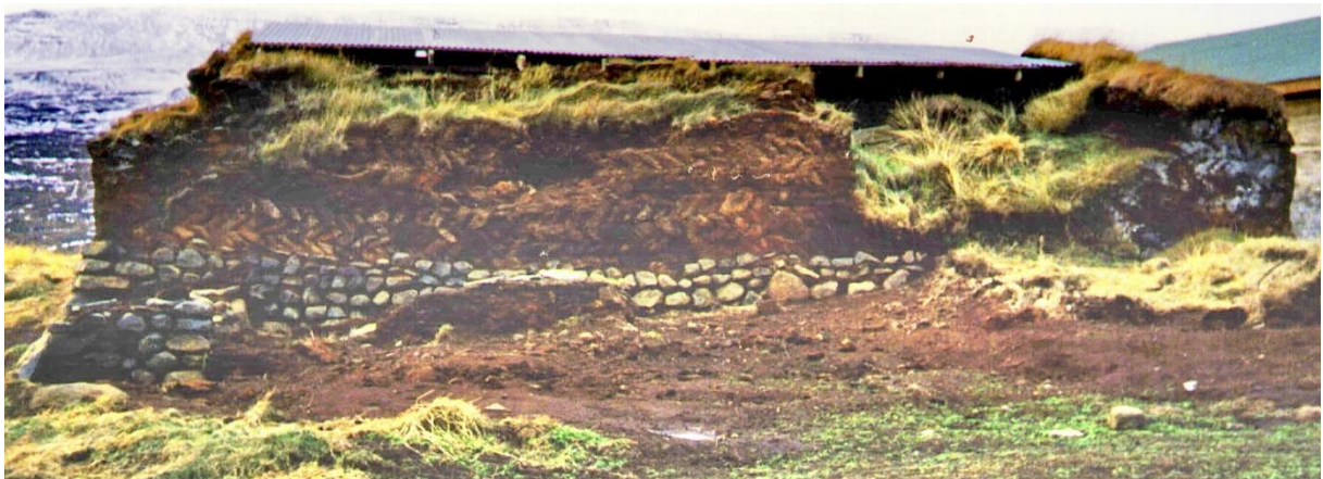
Mynd 100. Austurhliðin var biluð en hleðslan sást vel. Hornin voru ósködduð og öll hlaðin með klömbruhnaus. Talað var um að hlaða fyrir horn þegar klömbrur voru lagðar í hornin þannig að þau urðu ávöl í stað 90° horna sem mynduðust þegar hlaðið var úr hornhnausum og streng/Ljósm.SS-1998.
