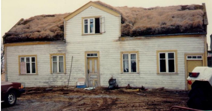
Mynd 65. Framhúsið á Völlum árið 1988. Torfbak var á húsinu en að öðru leyti var það án torfhlífar. Aftan við það var gamli torfbærinn og var gengið í gegn um framhúsið inn í göngin sem tengdu það við eldhús, búr, hlóðaeldhús og baðstofu sem var öftust húsa/Ljósm.SS-1988.
