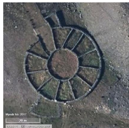
Mynd 117. Almennigur Hlíðarréttar, innsta rýmið, er fullkominn hringur. Innrekstrarhólfíð er hlaðið aðeins út fyrir hringform réttarinnar og þar er ágætur dilkur til viðbótar við þá ellefu sem ytri hringurinn gefur. Réttin er öll hlaðin upp eins og Hofsrett, úr framburði Jökulsár vestari og grjótið týnt upp af eyrunum í kring um hana. Hún er hlaðin úr þurru grjóti, þ.e. eingöngu grjóti (þurrmúr). Þegar réttir voru hlaðnar þurfti fyrst að ákveða hve margt fé almenningurinn varð að rúma, mæla fyrir stærð hans og hefja svo hleðsluna með því efni sem næst var. Réttarstæðið grjóthreinsaðist jafnótt og hlaðið var/Ljósm.SS-2003 og Loftmyndir ehf. 75
