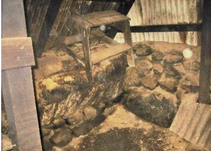
Mynd 158. Neðst í vegg er grjót í streng og klömbruhleðsla þar ofan á sem blasa við í hleðslum kofans og hafa örugglega verið margnotuð, í öðrum húsveggjum, áður en þau lentu þarna. Eldstó er á miðju gólfinu/Ljósm.SS-2009.
