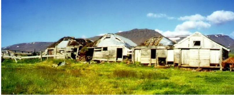
Mynd 196. Veggir fjárhúsanna voru hlaðnir með grjóti í streng í um meters hæð. Þar ofan á og upp úr var hlaðið með klömbruhnaus í streng/Ljósm.ABB-2000.
