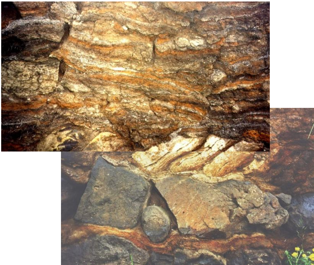
Myndir 74. Vesturveggur hlöðunnar á Krithóli gaf glögga mynd af margendurteknum uppgildingum og misjöfnu efni. Neðst voru nokkur lög af grjóti í streng. Ofan á þeim mátti greina eldgamlar, leirríkar, ljósleitar, klömbrur á tveimur stöðum. Ofan á þeim voru snidduhnausar úr roftorfi. Hlöðuveggurinn hafði greinilega verið tekinn niður að grjóthleðslum og gildaður upp. Óbilaðir leirríkir klömbruhnausar hafa fengið að halda sér og vitna um vel hlaðið hús á undan þessu. Roftorf getur verið þurrt og gott að því leyti en það tekur það langan tíma að „setjast til“, pressast og ná kyrrstöðu og það rýrnar og sígur eins og annað torf. Grjóthlaðnar undirstöður hlöðuveggjanna gætu hafa verið endurnýttar aftur og aftur, jafnvel öldum saman. Ef ekki átti að gjörbreyta legu eða gerð hússins var engin ástæða til að hrófla við vel settum og stöndugum veggjaundirstöðum/Ljósm.ABB-1999.
