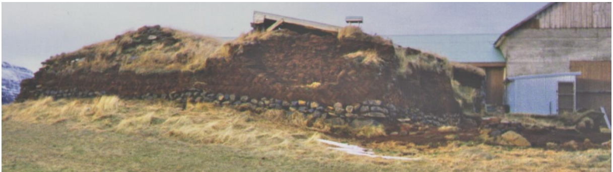
Mynd 99. Samskonar hleðslur voru á suðurhlið fjárhúsanna og þar sást að ytri hlið veggjanna hafði rofnað frá á pörtum og fallið burtu svo að sást í uppfyllinguna, sem virtist vera úr sundur þjökkuðu roftorfi og torfbindingu (sennilega strengjum). Hún var fremur laus í sér/Ljósm.SS-1998.
