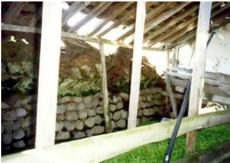
Mynd 197. Fjárhúsin voru fjögur, tvístæð, tví- og þríásá, ýmist garðaeða jötuhaus. Samtals átta krær. Við endurbætur á áttunda áratug 20. aldar voru þau hækkuð, ný grind var sett í þau og bárujárn klætt á þök. Timburpil var sett á alla gafla. Garðarnir voru að mestu leyti hlaðnir úr grjóti í streng, samskonar hleðslu og var í veggjum húsanna. Veggjagrjótið var fremur stórgert barið grjót. Í efstu lögum á innri hlið húsveggjanna var hlaðið veð klömbru í streng/Ljósm. ABB-2000.
