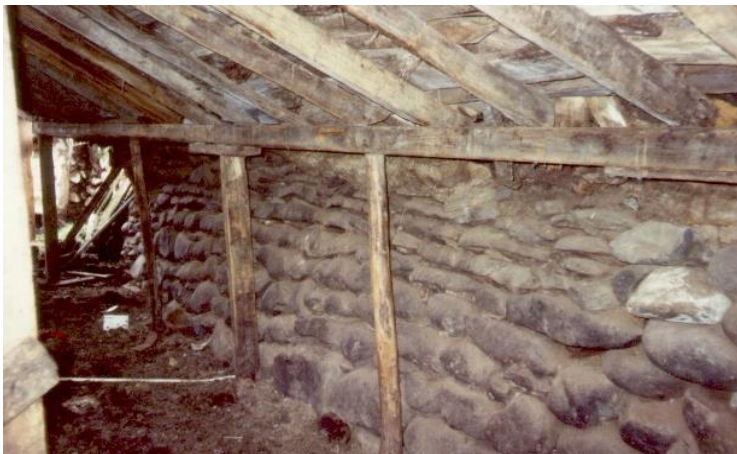
Mynd 130. Austurveggur fjárhúsanna séður innan frá. Húsið var tvær krær með um 40sm háum grjóthlöðnum garða í miðju. Garðaböndin voru úr grönnum borðum og voru negld á þrjár stoðir sín hvoru megin, sem lágu frá efri garðabrúnum upp í mænisás. Sylla (lausholt) lá á stoðum, sem stóðu á stoðarsteinum, út við vegg. Raftar voru lagðir frá syllu á mænisás. Áreftið var þétt á lagt en grindarviðir og aðrir þakviðir voru fremur gisnir. Létt viðað hús/Ljósm.SS-1990.
