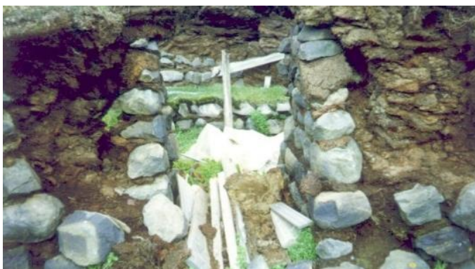
Mynd 105. Allir veggir hesthússins voru hlaðnir upp úr grjóti (skriðugrjóti) í streng og fylltir upp með torfi og jarðvegi. Þessir veggir voru um tveggja metra þykkir. Á myndinni er horft inn um dyr, á stallinn. Uppfyllingin í veggjunum var meira og minna úr afskurði, sem varð til þegar veggir voru snyrtir, og roftorfi (sennilega torfi úr gömlum, eldri veggjum). Hið sama mátti einnig sjá í fyllingu á Álfgeirsvöllum (mynd 88)/Ljósm.SS-1989.
