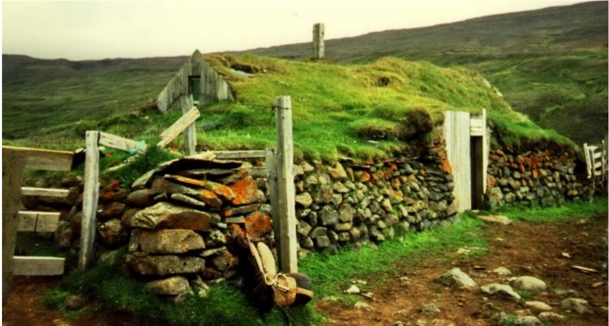
Mynd 113. Árið 1995 litu húsin á Þorljótsstöðum svona út. Hluti húsanna var þá notaður sem skjól fyrir smala og hestaferðafólk. Torfið, sem grjótið var lagt í upphaflega á ytri hlið veggjanna og batt hleðsluna saman, var allt burtu veðrað. Í enda hússins nær var svefnpláss. Eldavélinni var komið fyrir þar sem strompurinn (rörið) er/Ljósm.SS-1995.
