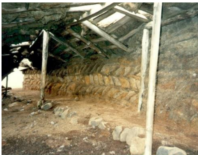
Mynd 111. Geithús voru einása jöтуhús. Ríflega meters breið jata var við langvegg norðurhússins. Fremst var einföld grjótröð. Lega mænisáss markaðist af jötubreiddinni og þess vegna var hann ekki alveg undir miðju húsinu. Stoðir hans stóðu á jötusteinum. Jötustokkar úr viðarborðum hafa verið negldir þar á. Jötubotninn var jafnhár gólfi en hann gæti hafa verið hækkaður með trégólfi. Stoðir voru undir lausholti á parti, á norðurvegg. Raftar lágu ýmist á lausholti eða á veggjunum. Stórgerður klömbruhnaus einkenndi húsin og óvenju lítið var af grjóti, miðað við fjárhús og miðað við að önnur hús í Breiðargerði voru grjótríkari. Geithús stóðu á lítilli hæð með torfrikum mýrarflóum á tvær hliðar þar sem auðvelt hefur verið að rista og stinga torf/Ljósm.SS-1989.
