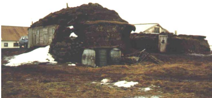
Mynd 160. Neðri myndin er af austurafli baðstofunnar. Hann var hlaðinn úr stórum klömbruhnausum en í suðurveggnum var grjóthleðsla í streng. Húsið til hægri var fjósið, sem var notað fram um 1990. Það var að mestu hlaðið upp með klömbruhnaus í streng. Í norðurvegg þess var grjót í streng ríkjandi hleðslugerð. Veggir þess voru um 2m þykkir. Valdimar Stefánsson, bróðir Fjólu, sá lengi vel um torfviðgerðir á Minni-Ökrum/Ljósm.SS-1987.
