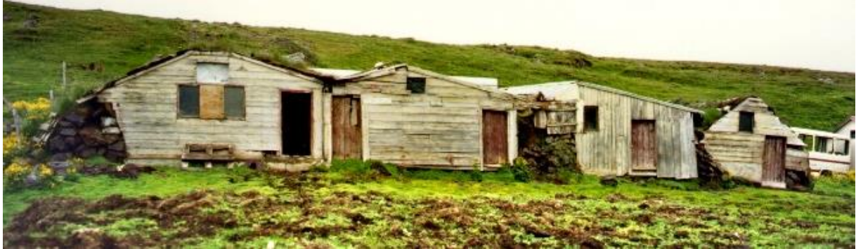
Mynd 70. Húsið lengst til hægri, nyrsta húsið, var síðast notað sem reykkofi. Það stóð aðeins aftar en hin húsin. Í syðsta húsinu voru hýstir nautgripir en þar hafði verið fjós fram á níunda áratug 20. aldar. Húsin tvö á milli fjóss (nautahúss) og reykkofa voru fjárhús/Ljósm.ABB-1999.
