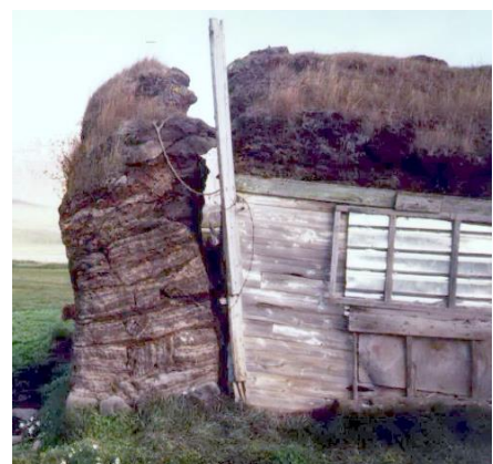
Mynd 164. Horn gaflhlaðsins við norðanverðan stafn framhússins voru hlaðin úr efnismiklum hornhnausum. Að öðru leyti var þessi gafl úr klömbruhnaus. Strengur var allsstaðar á milli hnausa/ SS-1988.
