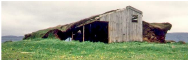
Mynd 109. Hlaðan stóð stök um 10 metrum austan við fjárhúsin. Bæði hlaðan og húsin voru hlaðin úr klömbruhnaus með streng á milli. Hlöðuveggir voru allir út torfi nema austurveggurinn sem var hlaðinn úr grjóti og streng/Ljósm.SS-1992.
