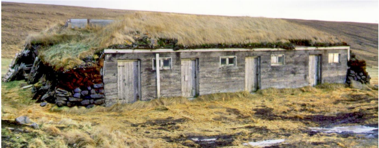
Mynd 98. Framhlið (vesturhlið) fjárhúsanna. Á húsunum voru upphaflegu hurðirnar. Norður-, austur- og suðurveggur, voru allir hlaðnir úr grjóti í streng upp í miðja vegg en þar ofan á úr klömbruhnaus, með strengbindingu. Nokkrum sinnum hafði verið gert við veggina eftir miðja 20. öld/Ljósm.SS-1998.
