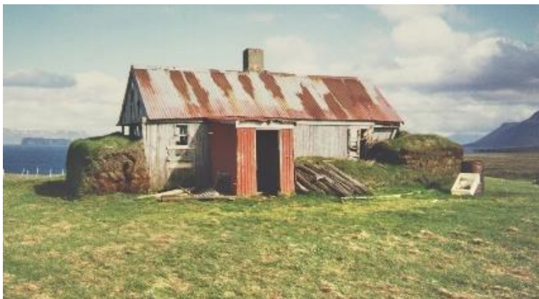
Mynd 23. Akurshúsið sem var byggt um 1940 er timburhús með bárujárnsþaki. Hálfveggir úr torfi voru við sinn hvorn gaflinn og að hluta til á langhliðum, greinilega til að hlífa húsinu. Ekki sást hvort neðsta hleðslulagið var grjótröð en veggirnir voru hlaðnir upp með fremur stórstungnum klömbrum með streng á milli laga. Samskonar língresi óx hér á hálfveggjunum eins og á veggjabrotum á Hrauni/Ljósm.SS-1994.
