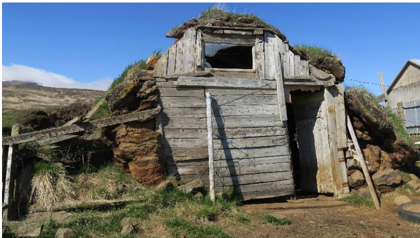
Mynd 81. Ofar. Búpeningshúsin voru meira og minna hlaðin úr grjóti og torfi/Ljósm.BZ-2018.
