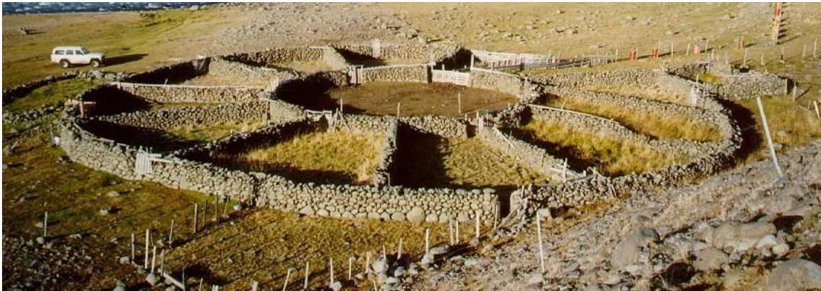
Mynd 117. Almennigur Hlíðarréttar, innsta rýmið, er fullkominn hringur. Innrekstrarhólfíð er hlaðið aðeins út fyrir hringform réttarinnar og þar er ágætur dilkur til viðbótar við þá ellefu sem ytri hringurinn gefur. Réttin er öll hlaðin upp eins og Hofsrett, úr framburði Jökulsár vestari og grjótið týnt upp af eyrunum í kring um hana. Hún er hlaðin úr þurru grjóti, þ.e. eingöngu grjóti (þurrmúr). Þegar réttir voru hlaðnar þurfti fyrst að ákveða hve margt fé almenningurinn varð að rúma, mæla fyrir stærð hans og hefja svo hleðsluna með því efni sem næst var. Réttarstæðið grjóthreinsaðist jafnótt og hlaðið var/Ljósm.SS-2003 og Loftmyndir ehf. 75
