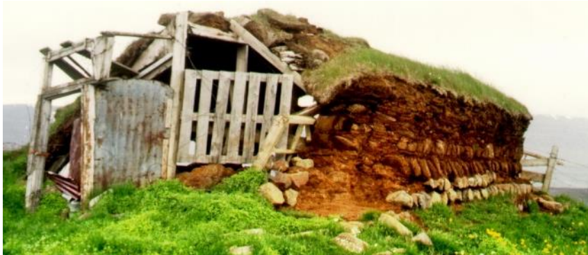
Mynd 86. Veggendi (kampur) var hruninn á suðvesturhorni hússins. Hornhnausar höfðu verið hnoðaðir í burtu svo sást í uppfyllinguna. Veggir voru að mestu hlaðnir úr klömbruhnaus í streng. Efst í veggjum var strengjahleðsla sem gæti hafa verið uppgilding á veggnum /Ljósm.ABB-1999.
