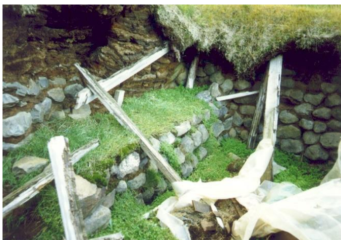
Mynd 106. Stallurinn í hesthúsinu var hlaðinn úr grjóti og torfi, eins og neðri veggglutarnir. Hæð á stalli var um 60sm. Grjóthleðslur vörðu sig betur en torfhleðslur gagnvart nagi, nuddi og rakadampi sem oft var raunin í búpeningshúsum. Jónas frá Hrafnagili sagði ástæðu grjóthleðsla þar þó fremur hafa tengst þeirri trú „að veggina að innan þyrfti að hafa úr eintómu grjóti svo hátt, að andi fjárins næði ekki til að leika um torfveggina, því að þá grotnaði hann og fúnaði undireins“. 67 Hver sem raunin var um trúna að þá gátu grjóthlaðnir veggir búpeningshúsa enst vel og lengi/Ljósm.SS-1989.
