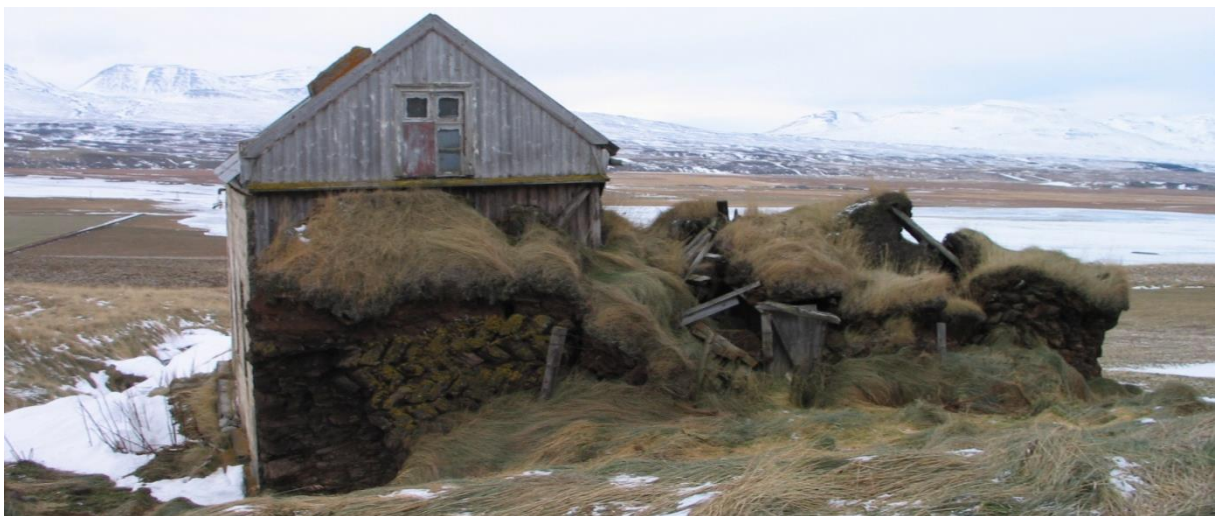
Mynd 157. Austurhlið Hrólfsstaðabæjar. Lengst t.h. er hlóðaeldhúsið með grjóthleðslu í streng upp undir miðja vegg í innri hliðinni og strenghlaðið þar ofan við. Samskonar hleðslur voru í gaflhlöðum að utan en ytri hlið langvegs, sem snéri í norður var að mestu hlaðin úr klömbruhnaus í streng. Fjósið var með samskonar hleðslum. Um meters þykkur skjólveggur var austan við húsið (lengst t.v.), sem var allur hlaðinn úr klömbruhnaus í streng. Grjót í streng var aðeins í tveimur neðstu hleðslulögum. Miðað við það sem eftir sást af grindarviðum voru bæði eldhúsið og fjósið eináa og voru stoðir við vegg. Á báðum húsunum virtust hafa verið sperrupök/Ljósm.SS-2006.
