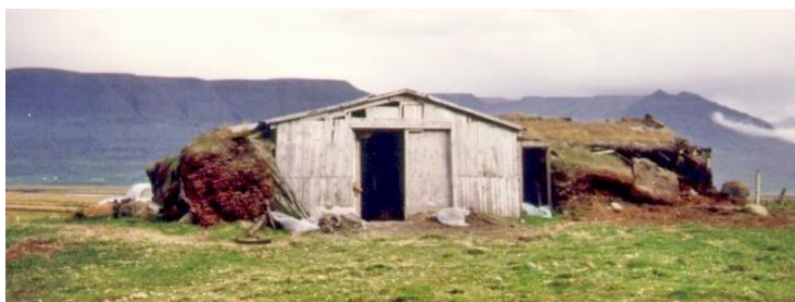
Mynd 63 sýnir nyrsta hluta fjárhúsanna. Strengur var mest áberandi í veggjum en hnaus, bæði klambra og snidda var líka notuð, s.s. í norðurvegg fjárhúsanna /Ljósm.SS-1988.
