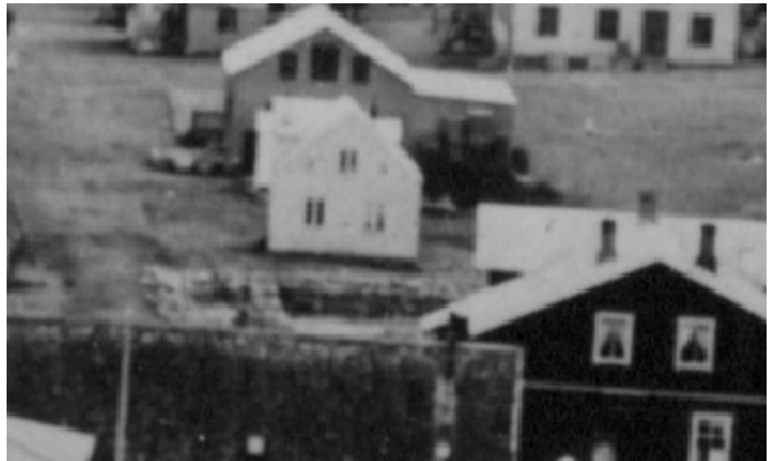
Mynd 15. Sauðárkrókur í kring um 1905. Steinhleðslan er líklega grunnur Péturshöndlunar sem brann 1902 og Uppsalar voru síðan byggðir á 1904. Hvíta húsið fyrir miðri mynd er Einarshús. Ljósmynd. HSK.
