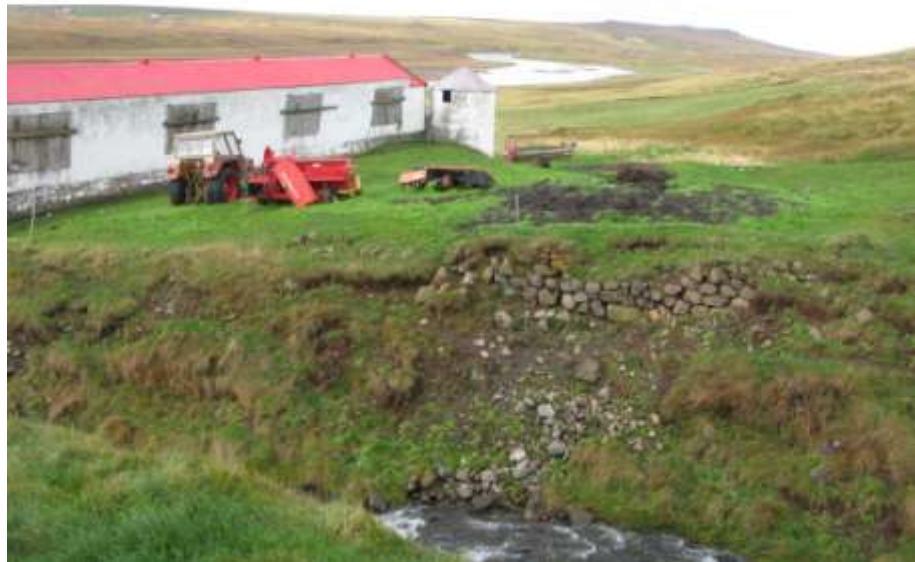
Mynd 9. Leifar Hólhúsanna. Horft er til vesturs.
