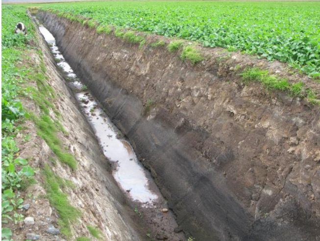
Mynd 36. Búið er að fylla í mógrafirnar en mór sést glögglega neðst í skurðinum. Horft er til asa.
