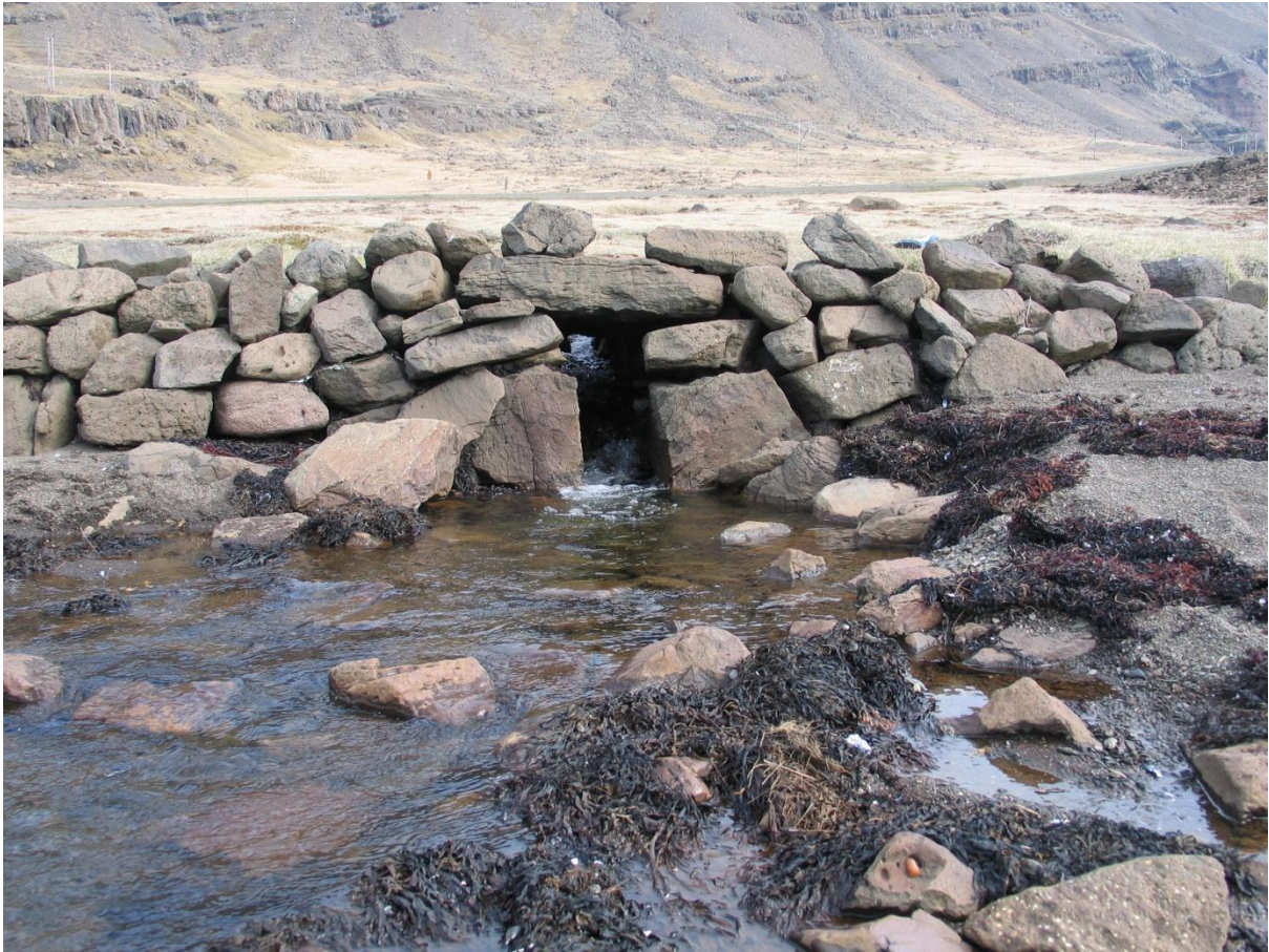
Horft til norðausturs yfir ræsi 1. Ljósm. GZ.
