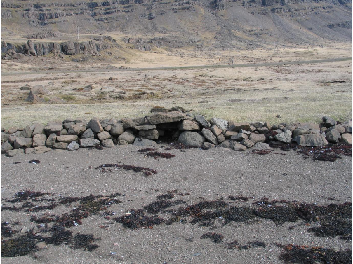
Horft til norðausturs yfir ræsi 3. Ljósm. GZ.
