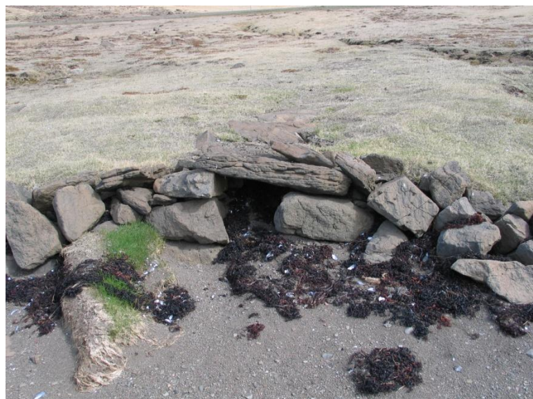
Horft til norðausturs yfir ræsi 2. Ljósm. GZ.
