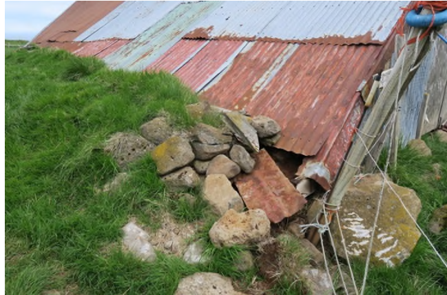
Mynd 10. Hleðslur úr gamla fjósinu.
