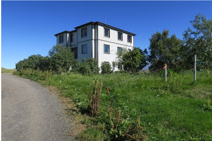
Mynd 5. Gamli bærinn stóð þar sem núna er garðurinn sunnan við íbúðarhúsið á Sjóvarborg 1. Horft er til norðausturs.
