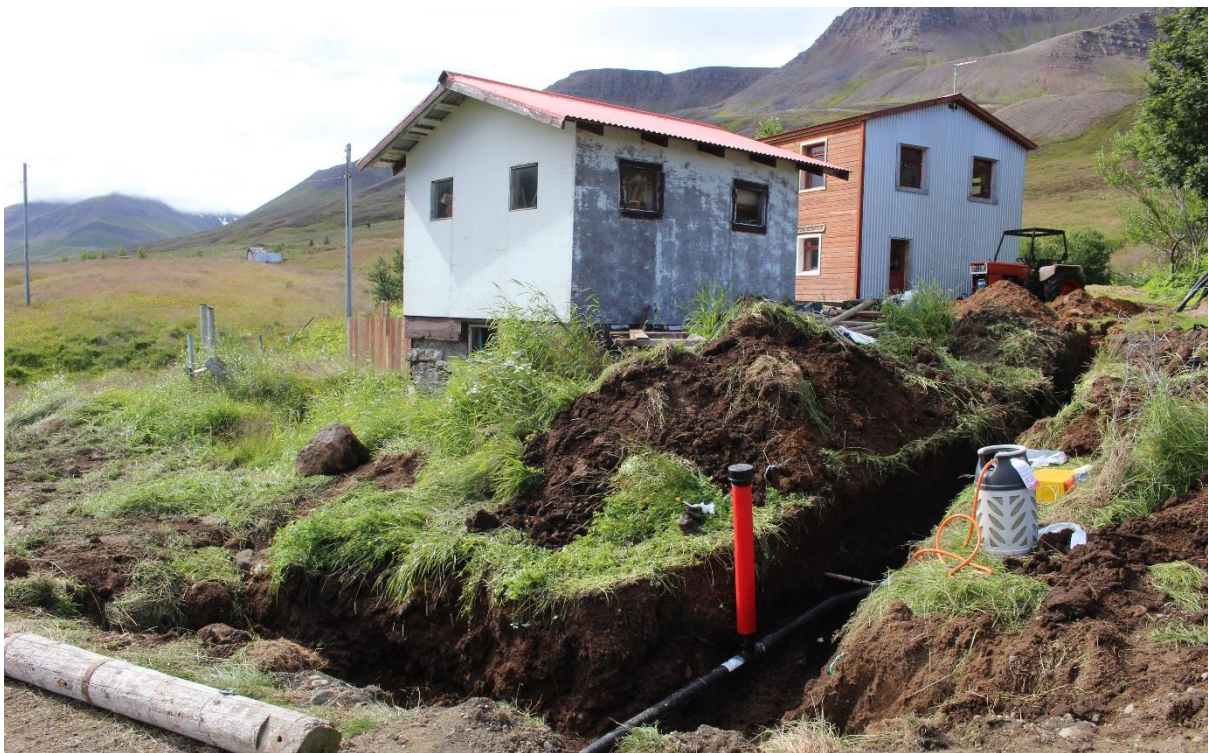
Mynd 1. Horft til suðvestur eftir lagnaskurði á Sjöundastöðum í Flókadal.
