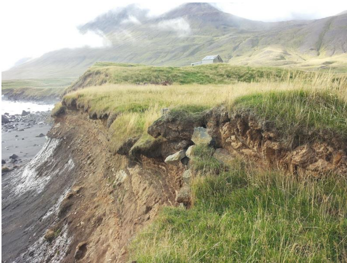
Mynd 26. Veggur sjóbúðartóftarinnar á sjávarbakkanum. Torf- og grjóthleðsla sést í sniðinu sem snýr að sjónum. Horft er til suðvesturs.
