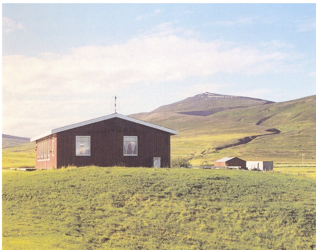
Gólfskálinn á Hlíðarenda. Mynd úr Byggðasögu Skagafjarðar I, bls 299.
