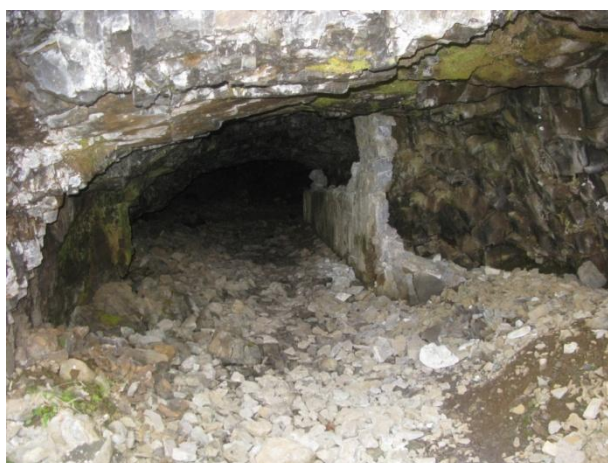
Séð inn í námagöngin og steypa vegginn sem nokkuð er fjarinn að hrynja. Ljós. Jóhann Zoëga.
