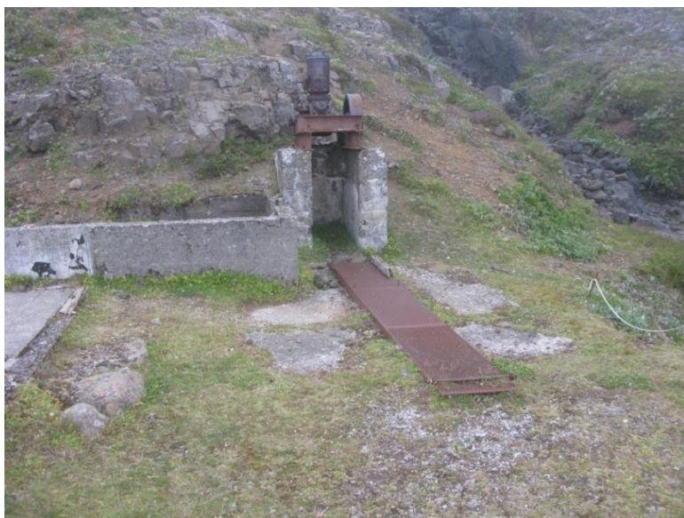
Mótorinn, undirstöður hans, leifar járnrennu og steinsteyptrar stéttar. Ljós. Jóhann Zoëga.
