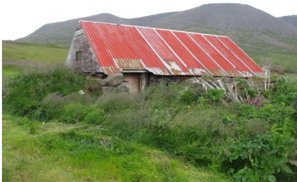
Mynd 13. Reykjofi á Balaskarði. Veggir hússins eru grjóthlaðnir og eru grunnur gamla bæjarins.
