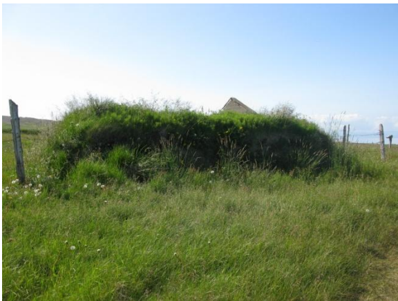
Mynd 33. Algróinn norðurveggur fjóssins.
