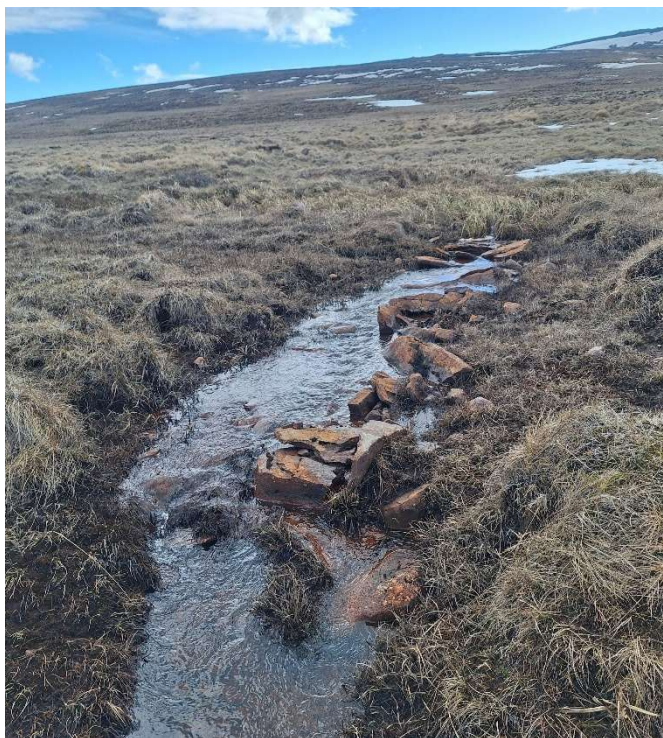
Mynd 14. Ræsi [3555-7] í gegnum veg [3555-2]. Horft til suðausturs.
