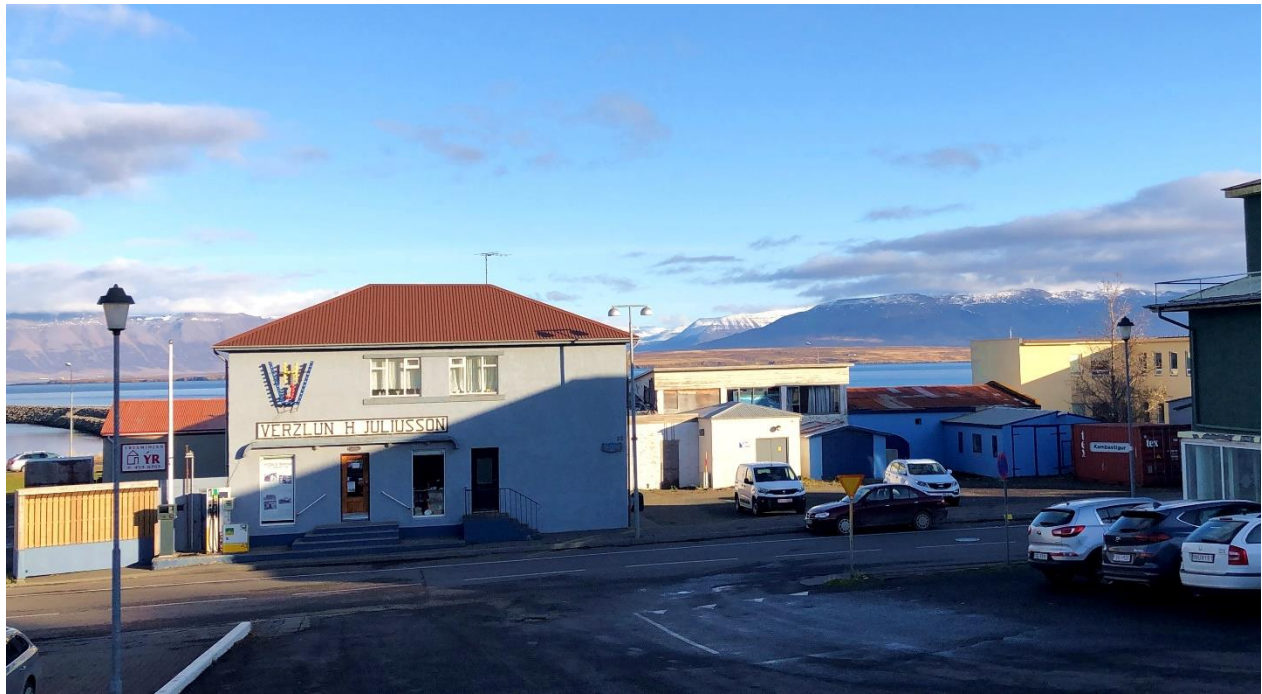
Mynd 9. Verslun H. Júl. og Leikborg - Aðalgötu 22b. Útfærslan nær í raun til beggja húsa þar sem Aðalgata 22b er í eigu Svf. Skagafjarðar og Bjarna Haraldssonar, sem hefur farið þess á leit við Byggðasafn Skagfirðinga að taka við versluninni. Leikborg er mikið líti á bænum eins og sakir standa, þar sem húsið og viðbyggingar eru í niðurníðslu. Húsin og umhverfi bjóða þó upp á mikla möguleika. Mynd: BSK/BP
