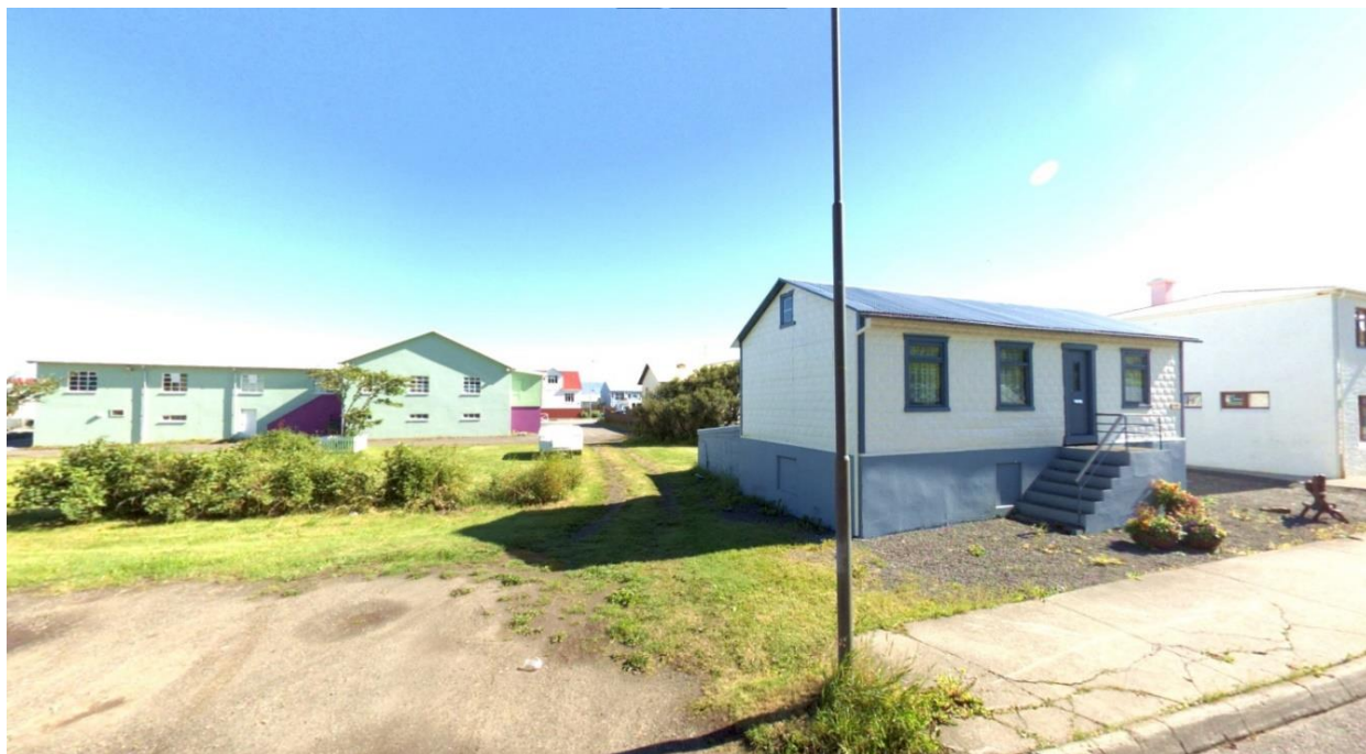
Mynd 1. Árbakki - Suðurgata 5. Í baksýn má sjá Félagsheimilið Bifröst. Á milli húsanna má sjá grænt svæði sem hugmyndin tekur til. Mynd: Skjaskot af Já.is.
