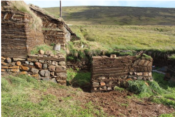
Mynd 1. Hreinsað var úr hesthúsinu 2008 og veggir hlaðnir upp að hluta en þeir síðan kláraðir fyrir grindarsmíðanámskeið 2015.
