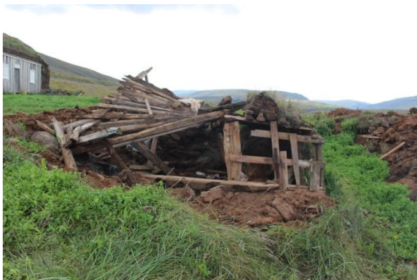
Mynd 5. Kofinn fram á hlaði áður en undirbúningur undir viðgerð hófst. Grindin féll árið 2014 en hafði fram að því staðið nokkuð vel.
