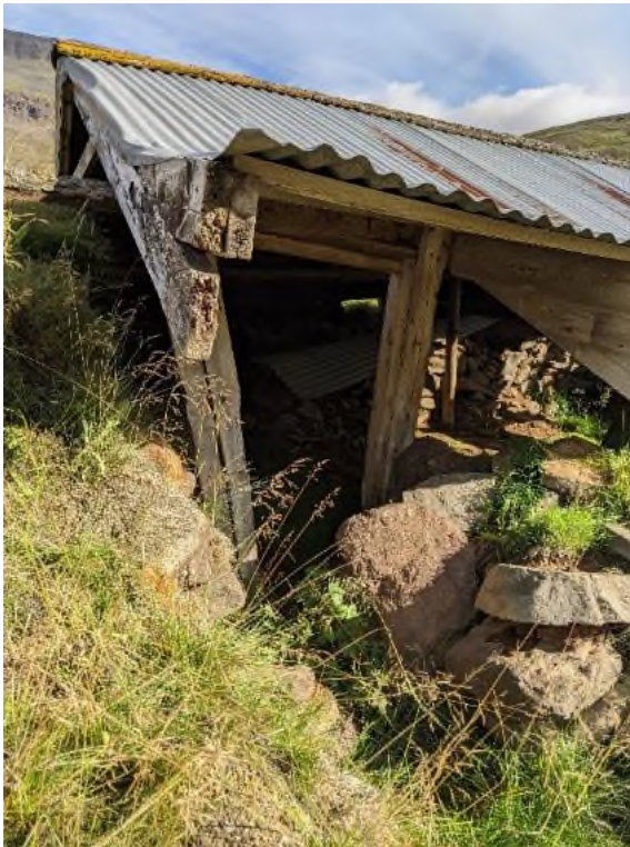
Mynd 68. Á vinstri mynd eru dyrnar en þær eru nyrst á suðurhlíð. Dyraumbúnaður hefur skekkst og grjóthleðslan við innganginn riðlast. Á hægri mynd er horft inn um dyrnar. Grjóthleðsla í norðurvegg er illa farin og bárujárn sem losnað hefur af þaki liggur inni í húsinu.
