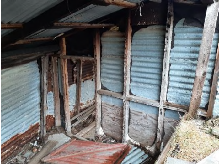
Mynd 77. Milliveggur úr einfaldri timburgrind, klæddur bárujárni og sömuleiðis útveggur til norðurs. Dyrnar liggja yfir í fremra herbergi hússins.
