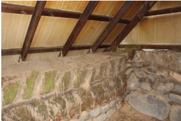
Mynd 30. Á vinstri mynd mætast norðurveggur (vinstri) og austurveggur sem er elsti veggur hússins. Torfhleðslan í norðurvegg eru klömbruhnausar með streng á milli. En austurveggur (hægri mynd) er að mestu leyti grjóthlaðinn í streng en efst er ein röð af klömbruhnaus.
