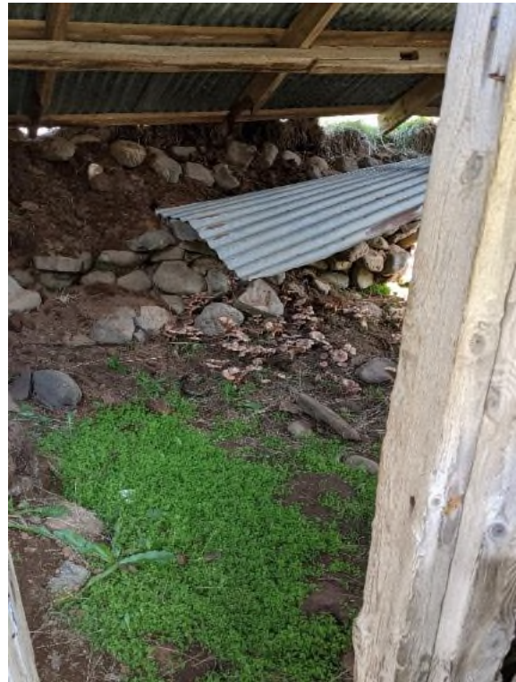
Mynd 68. Á vinstri mynd eru dyrnar en þær eru nyrst á suðurhlíð. Dyraumbúnaður hefur skekkst og grjóthleðslan við innganginn riðlast. Á hægri mynd er horft inn um dyrnar. Grjóthleðsla í norðurvegg er illa farin og bárujárn sem losnað hefur af þaki liggur inni í húsinu.
