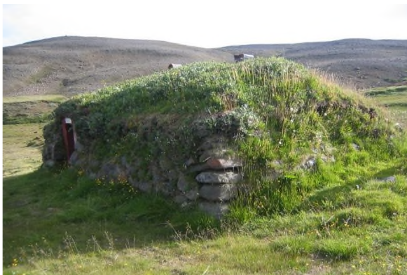
Mynd 72. Horn hússins er hlaðið úr stærri steinum sem svipar til hornhnausa í torfhleðslu. Ljósmynd: Hjalti Pálsson.
