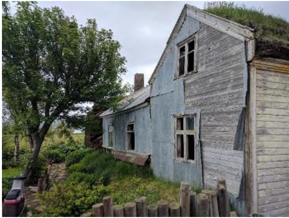
Mynd 127. Myndirnar eru teknar af suðurhlið framhússins, búrs og eldhúss sem voru bárujárnsklædd og torfgafli baðstofunnar sem hlaðinn er úr klömbruhnaus. Í neðsta hluta veggjar, sem er að líkindum eldri en efri hlutinn, er strengur á milli raða af klömbruhnaus en ofar er ekki strengur nema á einum stað, en á nokkrum stöðum sést í binding. Ljósmyndir: Guðmundur St. Sigurðarson.
