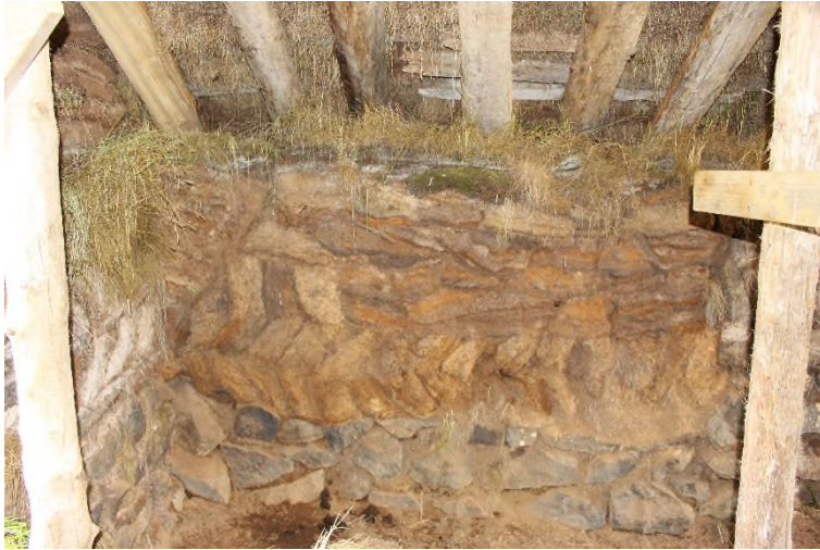
Mynd 59. Innsti hluti suðurveggjar er gamall og er hann hlaðinn úr grjóti í streng neðst, þar ofan við er klömbruhleðsla án strengjar og enn ofar er blanda af öðrum hnausum og streng.
