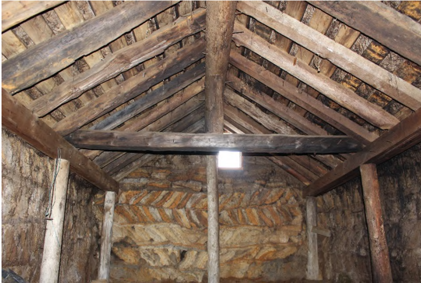
Mynd 52. Hlóðareldhúsið. Horft er í átt að austurvegg eldhússins og má sjá litarmismun á torfi sem líklega er vegna þess að efri hlutinn er uppgilding. Hleðslan í neðri hluta veggjar er nokkuð óvenjuleg en þar er hálf klömbruröðin látin halla til vinstri en hálf til hægri.
