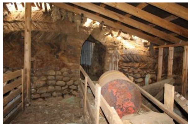
Mynd 15. Horft inn syðri fjárhúsin á Syðri-Brekkum. Þarna sjást vel sperrur í þakinu, stoðirnar og garðar til beggja handa. Á hægri myndinni sést í austurgaflinn. Á honum eru tvennar tóftardyr. Hann er vel hár og hlaðinn að mestu úr klömbruhnaus með streng á milli. Lengst til hægri má sjá tvær raðir af klömbrum sem snúa til sömu áttar.
