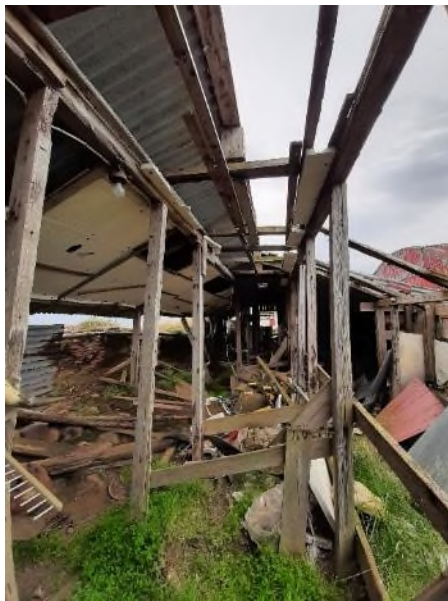
Mynd 35. Á hægri mynd er horft út fjósið og sést vel hversu illa farinn norðurhluti þaksins er. Á hægri mynd er horft inn húsin. Efst á mynd er strompurinn. Til hægri sést að hluti þaksins er einangraður með steinull og hluti klæddur með plötum.
