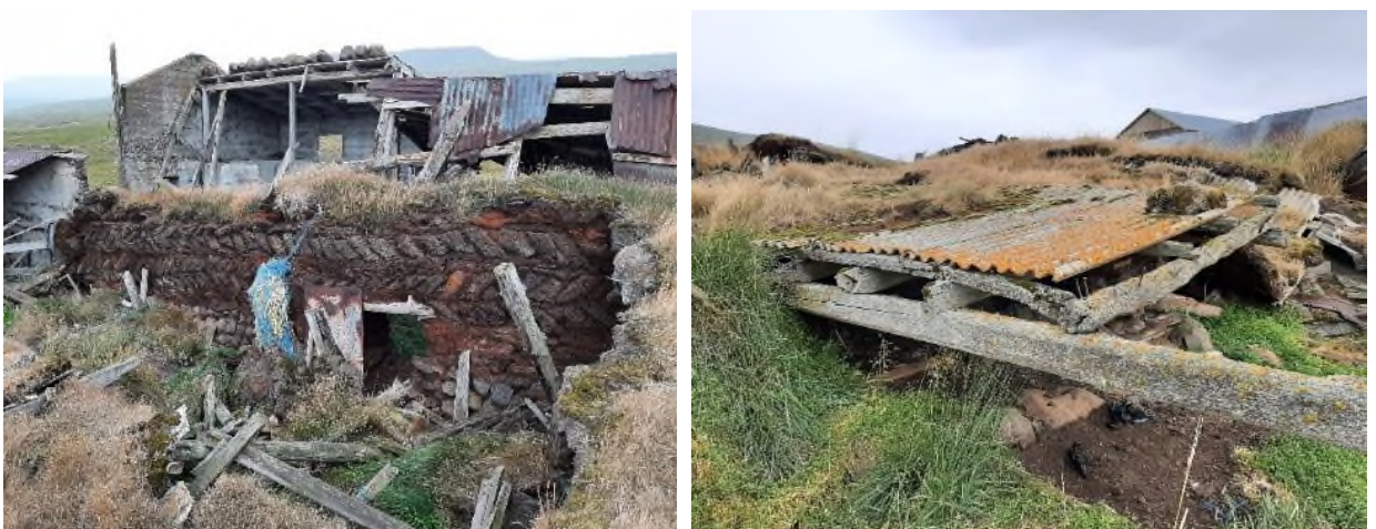
Mynd 84. Til vinstri er hlöðuveggur hlaðinn úr klömbruhnaus í streng og aftan við hann er yngri hluti fjóssins sem var steyptur og þak fjóshlöðunnar sem enn hangir uppi að hluta. Reft er yfir hlöðudyrnar. Til hægri er hluti af þaki fjárhúsa sem eru fallin. Þarna sést líklega í rafta og á þeim asbestplötur sem tyrft var yfir.
