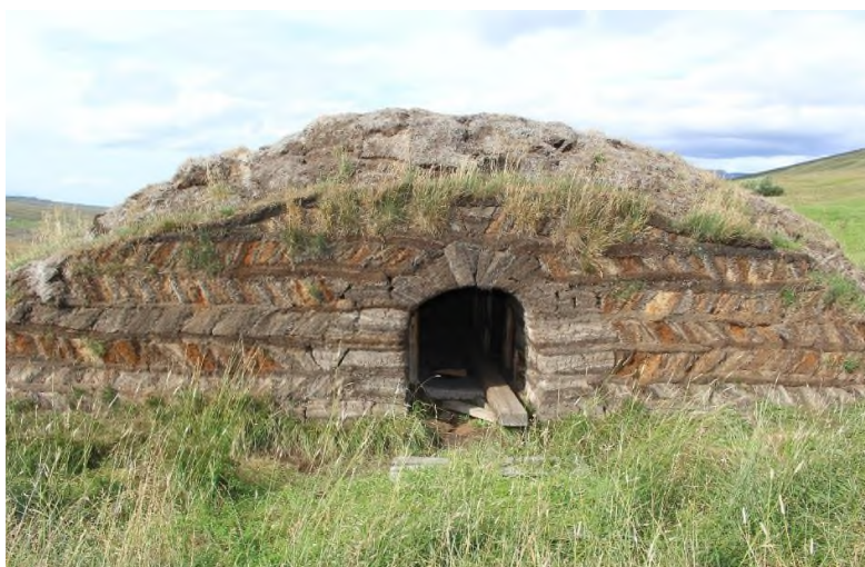
Mynd 61. Sunnan við húsin „suður og niður“ var heytíft og voru boghlaðnar (samhlaðnar) tóftardyr á milli heytóftar og fjárhúsa. Efri myndin er tekin af Sigríði Sigurðardóttur árið 1994 en neðri myndin árið 2021. Það var Helgi Sigurðsson hjá Fornverki ehf. sem hlóð dyrnar en veggurinn var endurhlaðinn á námskeiði Fornverkaskólans.
