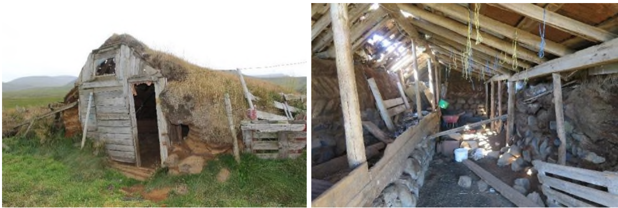
Mynd 81. Á myndinni til vinstri eru hesthúsin í Kolgröf í september 2021. Þau eru bæði farin að snarast fram (til austurs) og til suðurs. Á hægri mynd er horft inn húsinn, þar sést grjóthlaðinn stallur til vinstri.
