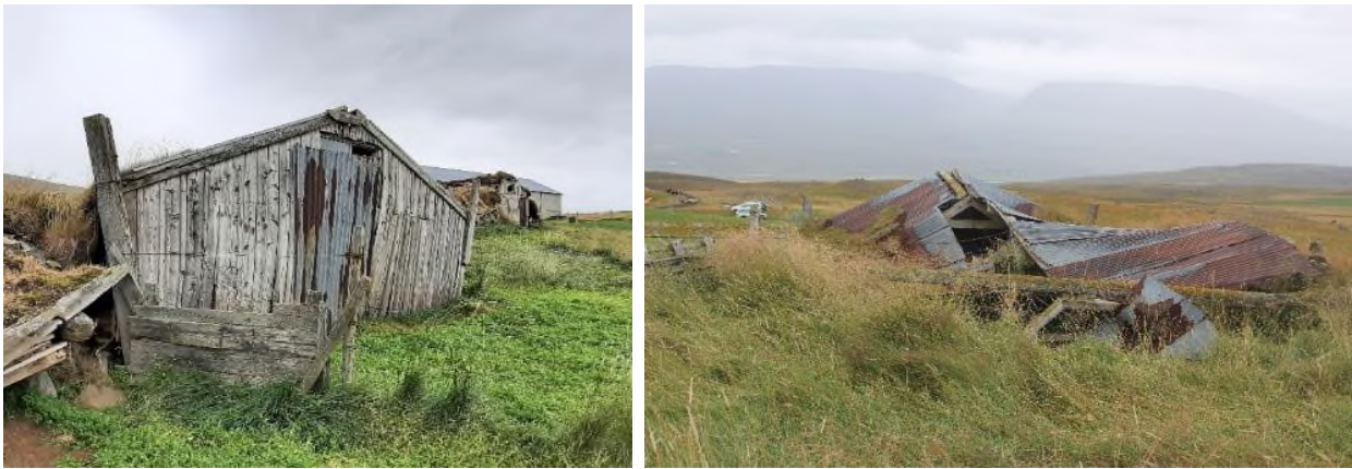
Mynd 83. Til vinstri er listaklætt timburpíl fjárhúsa og er það eina sem eftir stendur af húsinu. Á hægri mynd er síðan horft aftan frá og ofan á sama hús. Járn er á þaki og þar sem plötu vantar sést að þakið hefur verið með sperrum.
