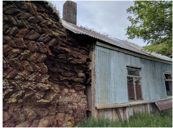
Mynd 127. Myndirnar eru teknar af suðurhlið framhússins, búrs og eldhúss sem voru bárujárnsklædd og torfgafli baðstofunnar sem hlaðinn er úr klömbruhnaus. Í neðsta hluta veggjar, sem er að líkindum eldri en efri hlutinn, er strengur á milli raða af klömbruhnaus en ofar er ekki strengur nema á einum stað, en á nokkrum stöðum sést í binding. Ljósmyndir: Guðmundur St. Sigurðarson.
