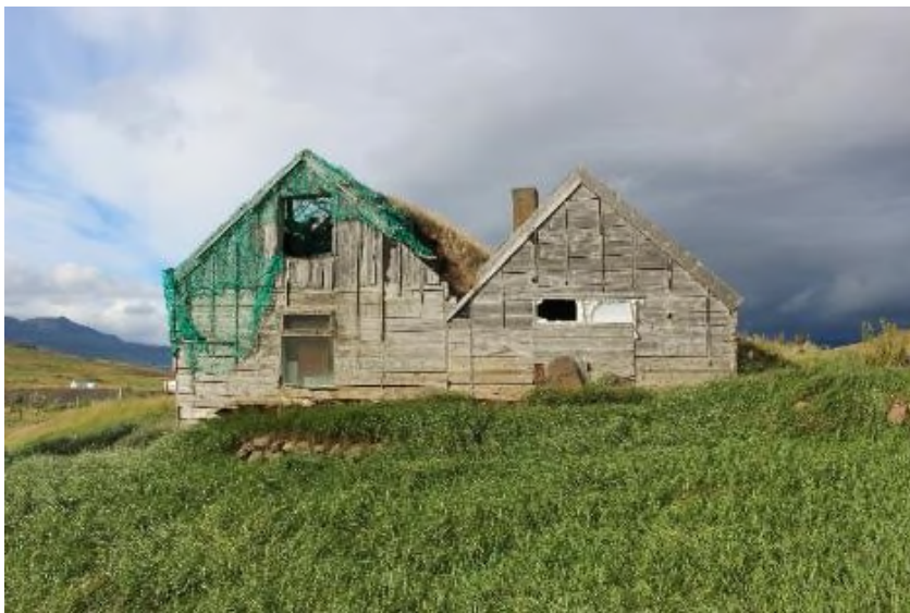
Mynd 102. Á efri mynd sést timburklætt frampil framhússins. Torfveggurinn sem var norðan við húsið (vinstra megin) er horfinn og lokað hefur verið fyrir norðurgaflinn með bárujárnsplötum. Á neðri mynd eru timburstafnar mót suðri og framan við þá lágur torf-og grjóthlaðinn veggur. Baðstofan var hægra megin við þessi hús en hún er alveg fallin.
