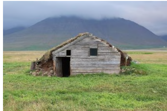
Mynd 19. Fjósið á Syðstu-Grund. Myndin til vinstri er tekin árið 1998 af Sigríði Sigurðardóttir en myndin til hægri haustið 2021. Á hægri myndinni er búið að rífa litla fjárhúskofann sem var norðan við fjósið.
