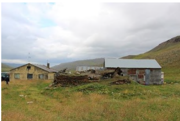
Mynd 108. Á mynd til vinstri sést í suðurhlið bæjarins. Neðsti hluti veggjar er hlaðinn úr grjóti í streng (þrjár raðir) en ofar er fremur stór hnaus, líkastur hornhnaus, notaður í allan vegginn. Á mynd til hægri er syðsti hluti bæjarins. Þar eru veggir hlaðnir úr grjóti í streng og sjást þrjár raðir af grjóti en ofar er hnaus.
