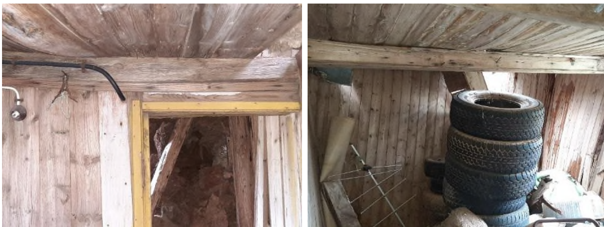
Mynd 99. Á mynd til vinstri eru dyrnar fram á gang með gulmáluðum lista. Vinstra megin við þær sést perustæði og rafmagnsleiðslurnar sem liggja fram á ganginn. Þarna sést líka í annan loftbitann. Á hægri mynd er einnig loftbiti og hafa verið listar meðfram honum. Á bakvið dekkinn er stigin upp á loft. Þiljur eru nokkuð heillegar undir stiganum en brotnar hægri megin við hann.
