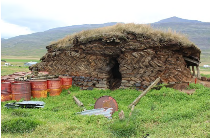
Mynd 91. Fjárhúsin í Þorsteinsstaðakoti í september 2021. Framhliðin er steipt en aðrir veggir torfhlaðnir. Á efri mynd sést á framhlið hússins en á neðri mynd er bakhliðin, torfhlaðin með boghlöðnum (samhlöðnum) tóftardyrum. Heytóftin er horfin. Á myndinni sést glögglega að ekki hefur verið notaður strengur á milli raða af klömbruhnaus.
