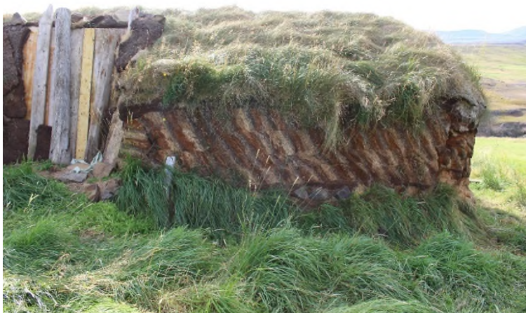
Mynd 64. Hlaðan var að hluta til hlaðin úr klömbruhnaus og snéru hnausarnir allir til sömu áttar og enginn strengur var á milli raða.
