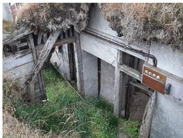
Mynd 98. Til vinstri er horft ofan í eldhúsið sem var múrhuðað (forskalað) að innan. Á suðurveggnum sést í vatnsleiðslur en kolaeldavél stóð við þennan vegg. Til hægri eru dyrnar út á ganginn. Hægra megin við eldhúsið var baðstofan og vinstra megin var búrið. Á hægri mynd er horft ofan í ganginn og þar var rafmagnstaflan. Um vinstri dyrnar var gengið í eldhúsið en um þær hægri yfir í baðstofuna sem þá var notuð sem svefnherbergi.
