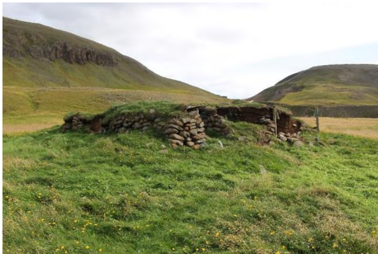
Mynd 112. Neðri-húsin á Giljum. Þak er að mestu fallið en hangir enn upp að hluta. Húsin eru að mestu hlaðin úr grjóti í streng.
