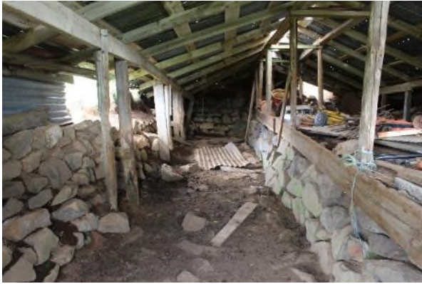
Mynd 18. Myndin til vinstri er tekin inn nyrðri króna í fjárhúsunum á Bjarnastöðum. Til vinstri á mynd er veggur úr grjóti í streng. Líklegt verður að teljast að torf hafi verið ofan á grjóthleðslunni eins og er innst í krónni. Grjóthlaðinn garði er til hægri og á honum standa stoðir. Gólfíð er flórað. Á hægri myndinni er horft yfir garðann og sér í stoðir útundir vegg í syðri krónni og timburpilið. Blandað sperru- og ásaþak er í húsunum, bárujárnsklætt.
