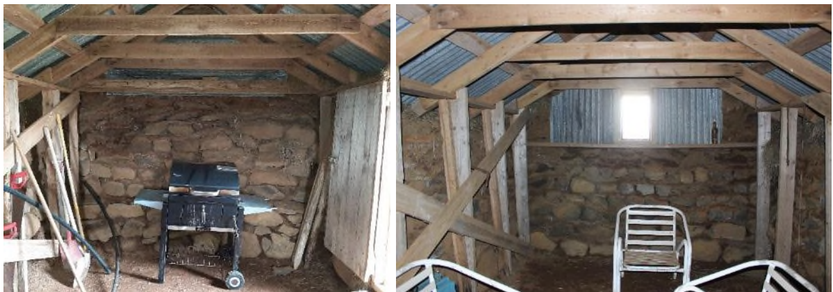
Mynd 124. Á vinstri mynd er norðurveggur Hraunlækjarkofa sem talinn er vera elsti veggurinn í húsinu. Á bakvið grillið er grjóthlaðinn stallur. Á hægri mynd er suðurveggurinn og glugginn sem var bætt við húsið við síðustu viðgerð.
