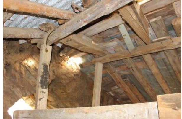
Mynd 14. Innst í nyrðri kró, nyrðri fjárhúsanna á Syðri-Brekkum. Húsin eru þríasa eins og sést á hægri mynd. Vaglar eru lagðir á milli hliðarása og kubbar (dvergar) ofan á þeim undir mæniásinn. Stoðir undir hliðarásnum standa á garðanum en stoðir undir syllum á gólfi. Til hægri er garðinn og við enda hans bogahlaðnar (samhlaðnar) dyr yfir í hlöðutóft. Fremur stórt grjót er í fjárhúsveggjum.
