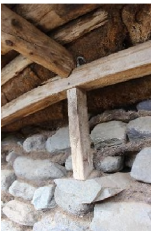
Mynd 113. Raftar lágu út á syllu sem haldið er uppi af litlum stoðum sem standa á grjóti í veggnum.
