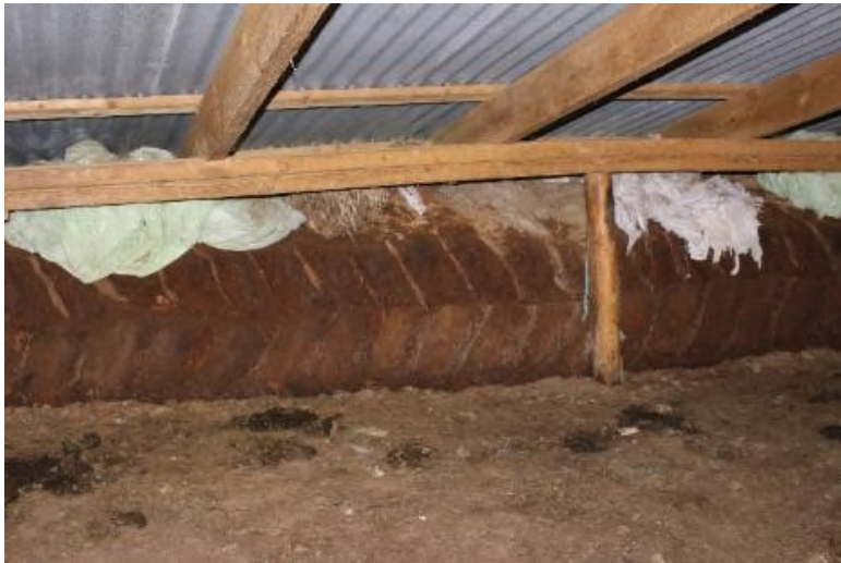
Mynd 116. Beitarhúsin á Giljum. Langveggir eru úr torfi- og grjóti en stafninn steypdur. Á neðri mynd sést í torfhleðslu úr klömbruhnaus. Ekki er strengur á milli.
