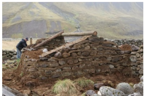
Mynd 70. Myndirnar sýna frá viðgerðinni/endurreisninni á kofanum sem fór fram dagana 12.-13. júní 2010. Veggir eru alfarið hlaðnir úr grjóti í streng og eins stallurinn. Ljósmyndir: Guðmundur St. Sigurðarson.
