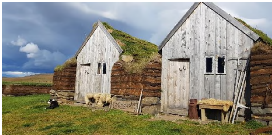
Mynd 137. Hesthúsin á Lýtingsstöðum og hestaréttin lengst til vinstri. Veggir eru hlaðnir úr hornhnausum og klömbruhnaus með streng. Torf er á þaki.
