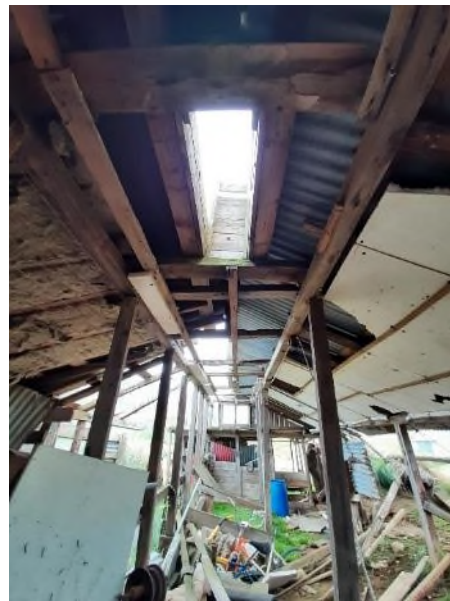
Mynd 35. Á hægri mynd er horft út fjósið og sést vel hversu illa farinn norðurhluti þaksins er. Á hægri mynd er horft inn húsin. Efst á mynd er strompurinn. Til hægri sést að hluti þaksins er einangraður með steinull og hluti klæddur með plötum.
