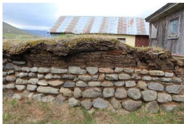
Mynd 109. Til vinstri er norðurendi gamla bæjarins, þ.e. fjósið og á bakvið það sést glitta í þil baðstofunnar og þak hesthússins. Til hægri er norður innveggur fjóssins. Neðst sex raðir af grjóti í streng og ofan við er torfhleðsla sem virðist helst blanda af þunnum aflöngum hnaus (sniddu) eða mjög þykkum streng í bland við mjórri streng.
