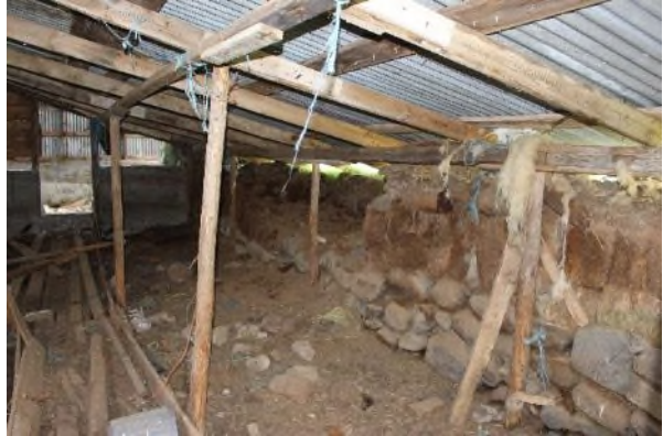
Mynd 111. Vinstri mynd er tekin inn í húsinu og er horft til vesturs í átt að frambílinu. Á hægri mynd sést suðurveggur hlaðinn úr grjóti í streng og torf þar ofan við. Stoðir sjást innan við útvegginn og á ytri brún garðans. Innst er steypur veggur milli fjárhúsa og hlöðu.
