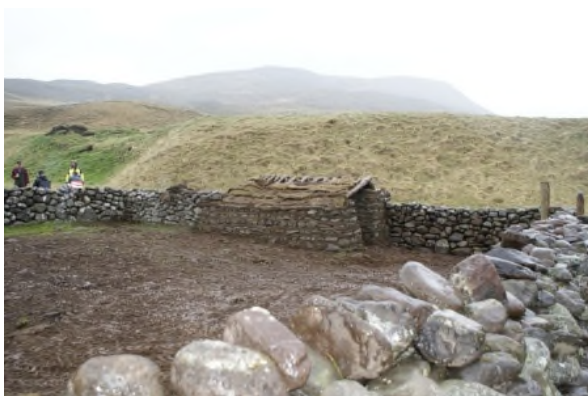
Mynd 70. Myndirnar sýna frá viðgerðinni/endurreisninni á kofanum sem fór fram dagana 12.-13. júní 2010. Veggir eru alfarið hlaðnir úr grjóti í streng og eins stallurinn. Ljósmyndir: Guðmundur St. Sigurðarson.
