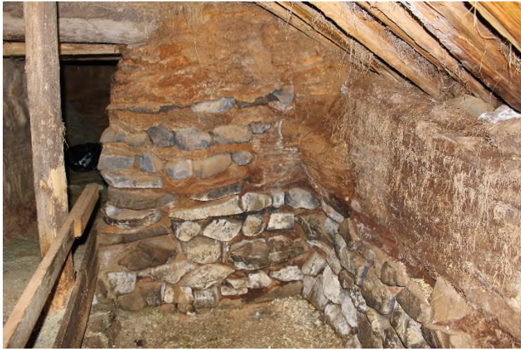
Mynd 63. Í syðri kró nyrðri húsanna er austurveggur gamall og má sjá í honum uppgildingar. Til hægri er suðurveggurinn hlaðinn úr streng. Neðsti hluti veggjar er allur úr grjóti í streng.
