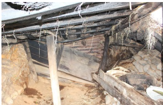
Mynd 5. Myndirnar sýna hús þar sem eigendur hafa gert ráðstafanir til þess að verja húsin. Á efstu mynd til vinstri er búið að hengja staur meðfram torfveggnum til að varna því að hestar nagi húsin. Á hægri myndinni hefur net verið sett yfir þakið til að varna foki og á neðstu myndinni hefur stoð verið skotið undir rafta til þess að styðja við þakið.
