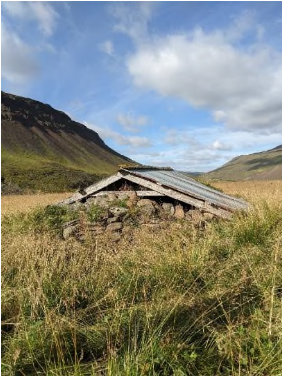
Mynd 66. Vinstri mynd er af austurgafli fjárhússins (seinna hesthúss) í Ábæ. Húsið er niðurgrafið og því sést bara efri hlutinn. Gaflinn er hlaðinn úr grjóti. Hægri myndin er tekin inn í húsinu og þar sést að grjótið er ekki hlaðið í streng, nema í tveimur mjóum röðum. Efsta hluta veggjar vantar. Sperrupak er á húsinu og bárujárn á þaki.
