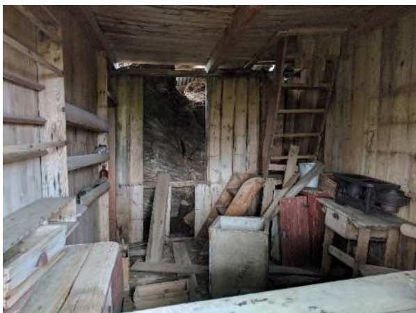
Mynd 129. Búrið á Völlum var alþiljað hús og þaðan lá stigi upp á loft. Norðurveggur er brotinn og sér í torfvegginn sem var milli búrs og hlóðaeldhúss. Vinstra megin við búrið var eldhús og hægra megin var sparistofan í framhúsinu. Ljósmyndir: Guðmundur St. Sigurðarson.
