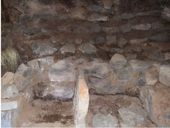
Mynd 122. Á vinstri mynd eru hlóðirnar í eldhúsinu en þær eru taldar vera frá því um aldamótin 1800. Hlóðirnar eru tvöfaldar eins og sést og er ein hella á milli þeirra sem stendur upp á rönd. Til hægri er norðausturveggurinn og á honum dyr. Ofan við dyrnar sést gömul torfhleðsla með klömbruhnaus í streng og alveg efst sést í enda mæniássins og rafta. Grind og þak eru nýlega viðgerð.
