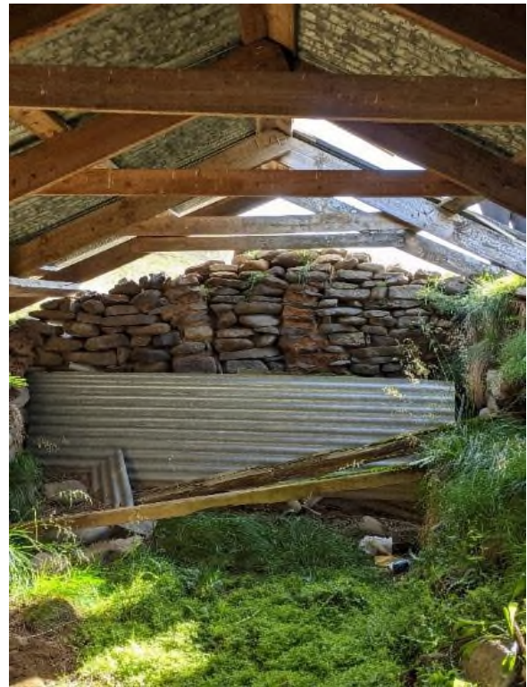
Mynd 66. Vinstri mynd er af austurgafli fjárhússins (seinna hesthúss) í Ábæ. Húsið er niðurgrafið og því sést bara efri hlutinn. Gaflinn er hlaðinn úr grjóti. Hægri myndin er tekin inn í húsinu og þar sést að grjótið er ekki hlaðið í streng, nema í tveimur mjóum röðum. Efsta hluta veggjar vantar. Sperrupak er á húsinu og bárujárn á þaki.
