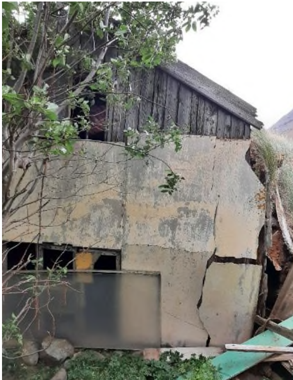
Mynd 25. Á vinstri mynd má sjá stafn eldhússins, sem er með standandi timburþili og klæddur með asbestplötum. Á myndinni til hægri er suðurstafn baðstofunnar sem féll veturinn 2019/20. Hann var líka með timburþili og sést að húsið hefur verið grænmálað að innan.
