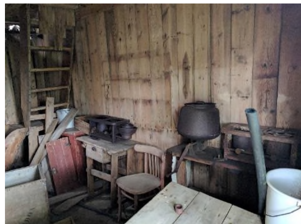
Mynd 129. Búrið á Völlum var alþiljað hús og þaðan lá stigi upp á loft. Norðurveggur er brotinn og sér í torfvegginn sem var milli búrs og hlóðaeldhúss. Vinstra megin við búrið var eldhús og hægra megin var sparistofan í framhúsinu. Ljósmyndir: Guðmundur St. Sigurðarson.
