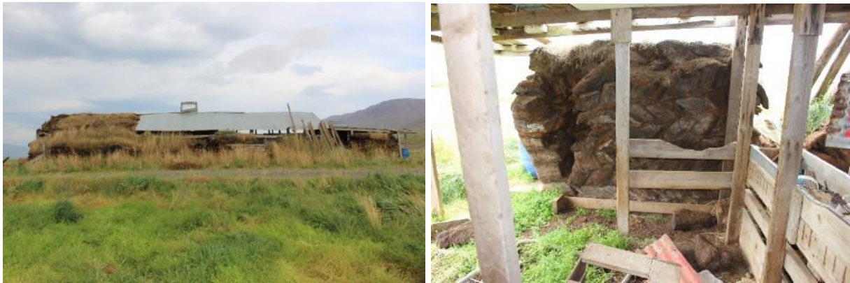
Mynd 36. Á myndinni til vinstri sést suðurhlið fjóssins á Minni-Ökrum. Sá hluti hússins sem er með torfpaki er elsti hluti byggingarinnar. Lengst til hægri er viðbygging frá 7. áratug síðustu aldar, með flötu þaki. Á hægri mynd sést torfveggur úr viðbyggingunni hlaðinn af Valdimari Stefánssyni frá Þverá. Klömbruhnaus með streng á milli og hornhnausar við veggendann.
