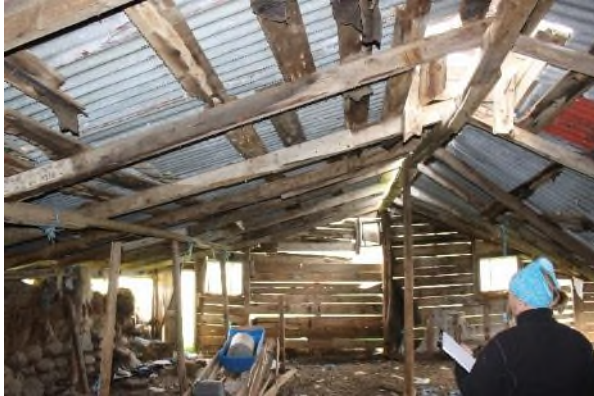
Mynd 111. Vinstri mynd er tekin inn í húsinu og er horft til vesturs í átt að frambílinu. Á hægri mynd sést suðurveggur hlaðinn úr grjóti í streng og torf þar ofan við. Stoðir sjást innan við útvegginn og á ytri brún garðans. Innst er steypur veggur milli fjárhúsa og hlöðu.
