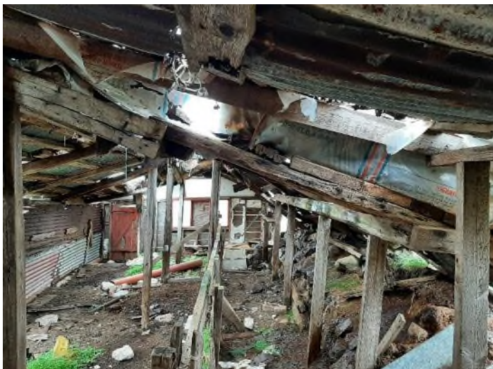
Mynd 75. Horft vestur eftir húsinu að frambili. Fyrir miðri mynd er fódurgangurinn og hægra megin hans, sylla með stoðum og leifar útveggjar úr torfi. Stoðir eru undir tveimur ásum.
