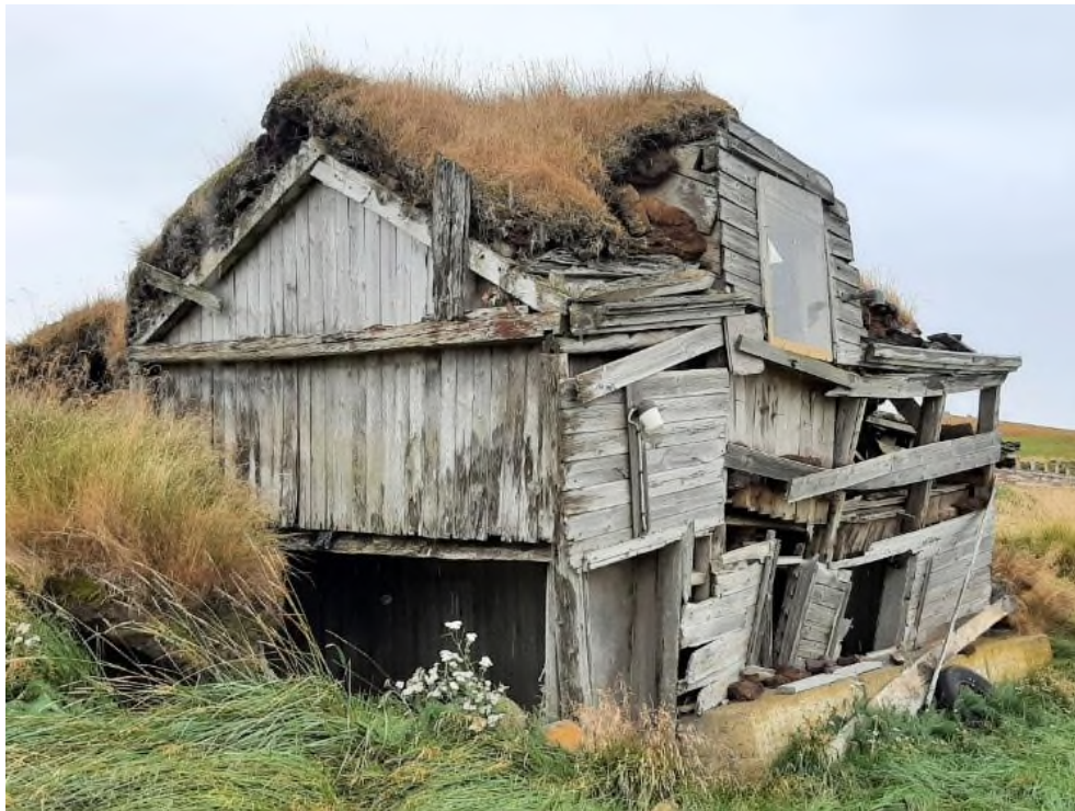
Mynd 96. Norður- og framhlið framhússins. Lengst til vinstri sést í restina af torfveggnum sem var milli bæjarganga og hlóðældhúss. Neðst fyrir miðri mynd er útidyra hurðin og innan við hana sést í bæjardyrnar. Frambilið er mjög illa farið en útiljósíð er enn á sínum stað.
