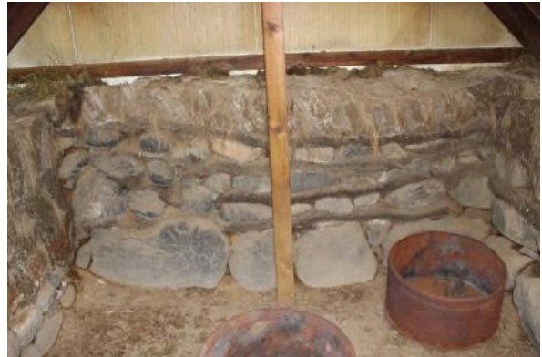
Mynd 30. Á vinstri mynd mætast norðurveggur (vinstri) og austurveggur sem er elsti veggur hússins. Torfhleðslan í norðurvegg eru klömbruhnausar með streng á milli. En austurveggur (hægri mynd) er að mestu leyti grjóthlaðinn í streng en efst er ein röð af klömbruhnaus.
