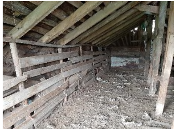
Mynd 21. Efst til vinstri má sjá frambilið og norðurvegg gamla fjóssins. Staur hefur verið hengdur meðfram veggnum til að verja hann fyrir skepnum. Efst til hægri er horft á suðaustur horn hússins. Austurgafi, suðurveggur og suðurhlið hússins eru orðin ansi illa farin. Á neðri mynd til vinstri er horft undir jötuna á torfvegg sem hlaðinn er úr klömbruhnaus án strengjar. Neðst á mynd sést í gúmmímottur sem búnar eru til úr gömlum dekkjum og voru hafðar undir hestunum. Neðst til hægri er svo horft inn húsin úr dyrunum. Veggur hefur verið klæddur að innan með timbri.
