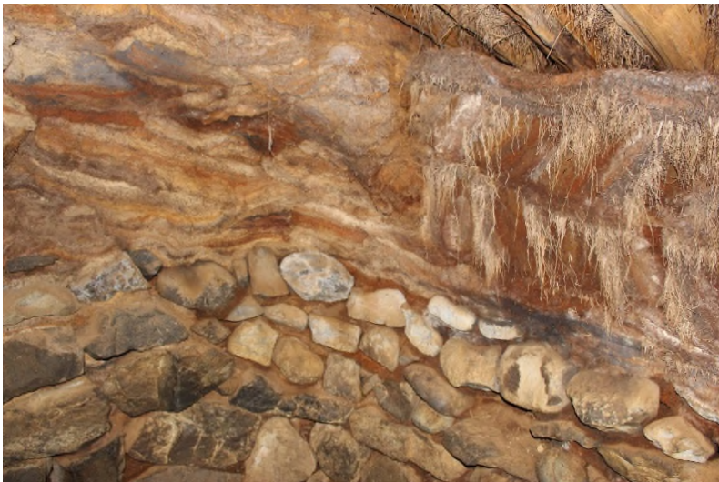
Mynd 65. Á efri mynd eru Hólhúsin í september 2021. Húsin hafa verið í notkun frá árinu 2009. Á neðri mynd sést hvar gamlar og nýjar hleðslur mætast. Neðst er grjót í streng en ofar til hægri klömbruhleðsla með streng. Til vinstri er strengur en ofan við eru líklega hnausar.
