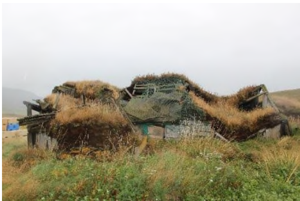
Mynd 97. Á vinstri mynd er suðurhlið bæjarins í Breiðargerði. Lengst til vinstri er framhúsið, þá svefnherbergi og síðan baðstofan til hægri. Á myndinni til hægri er austurgöfl baðstofunnar, hlaðinn að mestu úr torfi. Til hægri við baðstofuvegginn er eldhúsið.
