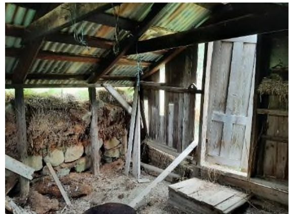
Mynd 90. Á vinstri mynd er austurveggurinn í reykkofanum. Hann er hlaðinn úr grjóti í streng neðst en klömbruhnaus með streng að ofan. Til hægri sést innan á framþil hússins sem er orðið nokkuð gisið.
