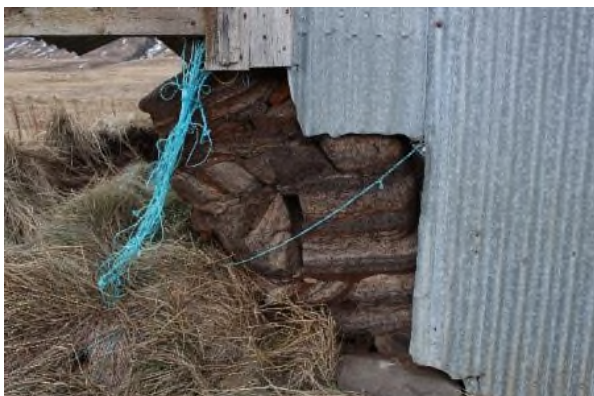
Mynd 43. Á vinstri mynd má sjá vesturenda norðurlangveggjar. Til hægri eru hornhnausar en til vinstri klömbruhnaus. Á myndinni til hægri er horft inn húsin. Þar sjást stoðir undir mæniás en fyrir miðri mynd sjást stoðir sem festar eru á garðann. Járn af norðurenda þaks er að miklu leyti horfið.
