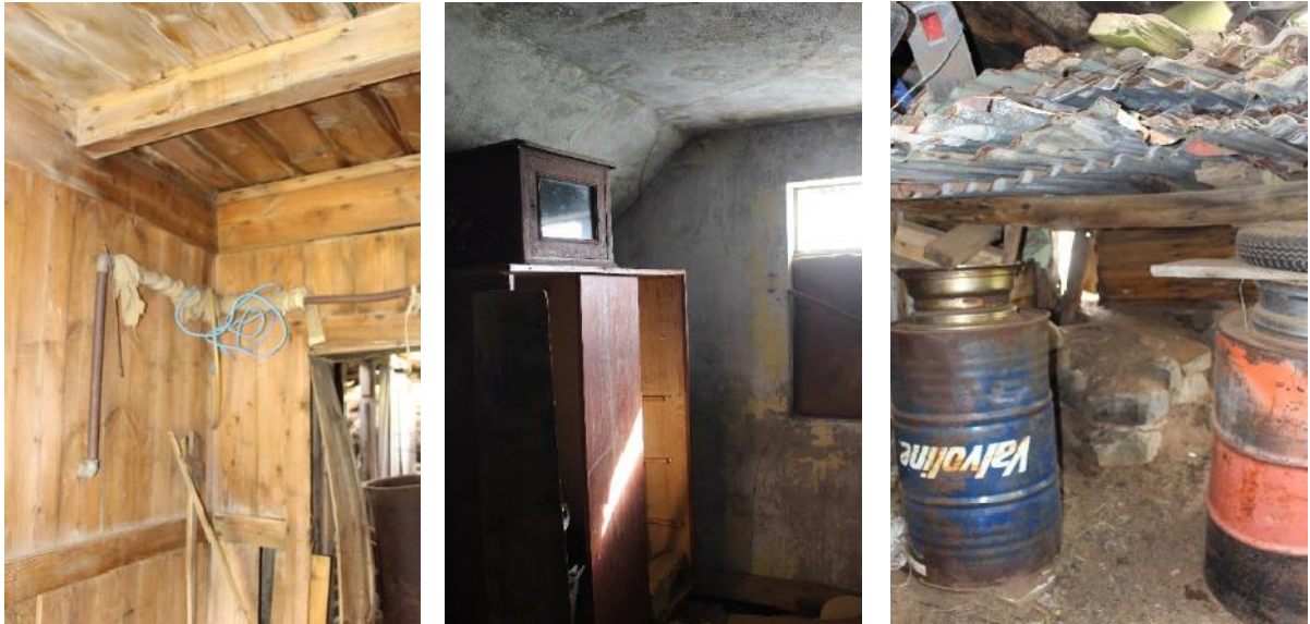
Mynd 103. Myndin lengst til vinstri sýnir hluta af þiljuðum bæjardyrnum. Hurðin til hægri liggur yfir í eldhúsið. Fyrir miðju er mynd tekin inn í syðsta herbergið, sem er múrhúðað (forskalað). Á myndinni lengst til hægri er horft inn í það sem líklega var hlóðaeldhús. Þarna er þakinu að hluta til haldið uppi með tunnum sem á eru felgur og fleira dót. Á milli tunnanna sést í grjóthleðslu sem líklega eru hlóðir.
