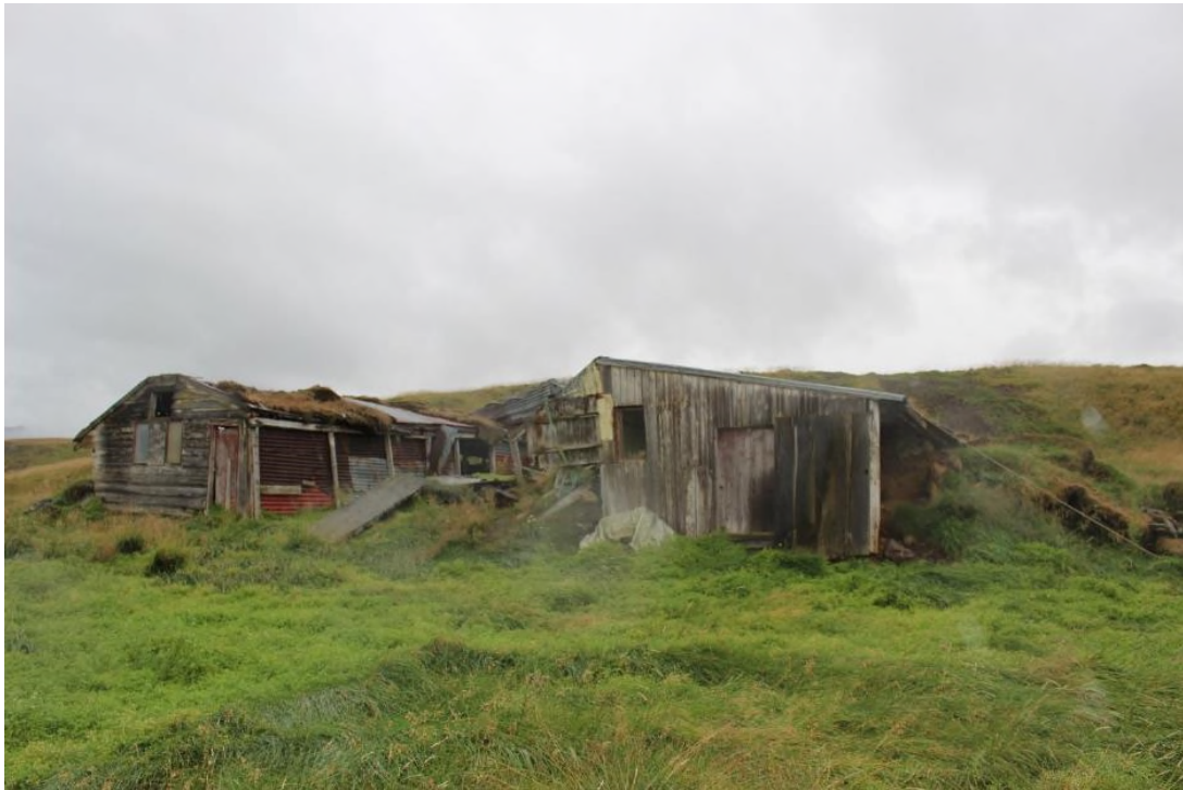
Mynd 73. Húsið til vinstri var upphaflega fjárhús en síðar notað sem fjós en húsið hægra megin var hesthús. Fjárhús var á milli þessara tveggja húsa og reykkofi var lengst til hægri á mynd.
