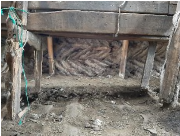
Mynd 21. Efst til vinstri má sjá frambilið og norðurvegg gamla fjóssins. Staur hefur verið hengdur meðfram veggnum til að verja hann fyrir skepnum. Efst til hægri er horft á suðaustur horn hússins. Austurgafi, suðurveggur og suðurhlið hússins eru orðin ansi illa farin. Á neðri mynd til vinstri er horft undir jötuna á torfvegg sem hlaðinn er úr klömbruhnaus án strengjar. Neðst á mynd sést í gúmmímottur sem búnar eru til úr gömlum dekkjum og voru hafðar undir hestunum. Neðst til hægri er svo horft inn húsin úr dyrunum. Veggur hefur verið klæddur að innan með timbri.
