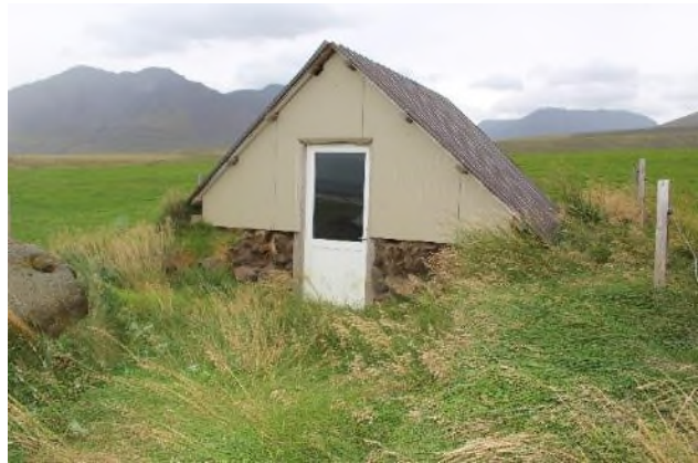
Mynd 28. Til vinstri eru Hringshúsin árið 2007 en myndin til hægri er tekin 2021. Búið er að skipta út bárujárnsklæðningu fyrir yl-einingar.
