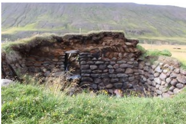
Mynd 115. Til vinstri er horft ofan í hlöðuna. Veggir eru að mestu hlaðnir úr grjóti í streng en efst sést m.a. í klömbruhnaus með streng á milli. Til hægri er horft inn í nyrðri húsin. Það sem sést af norðurvegg er alfarið hlaðið úr grjóti í streng. Meirihluti þaksins er fallinn en húsin stóðu vel fram yfir 1991 og voru í notkun fram á þessa öld.
