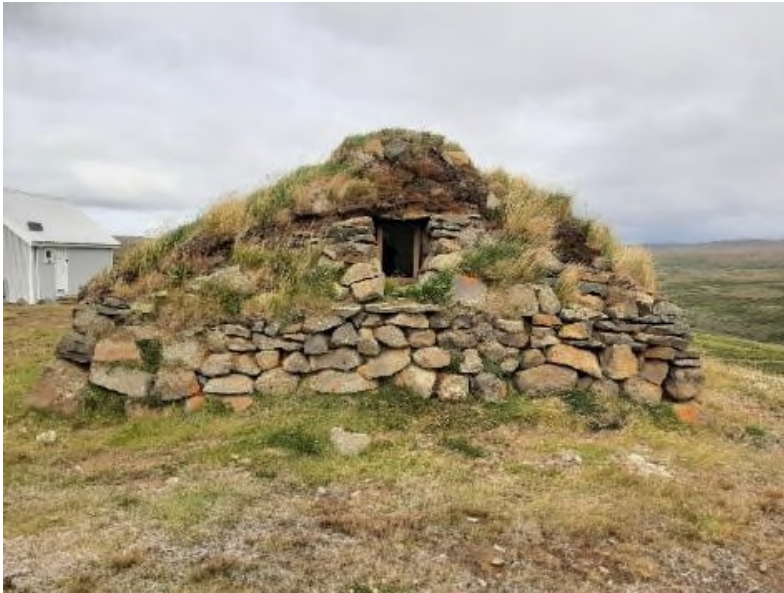
Mynd 123. Á efri mynd sést framan á Hraunlækjarkofann en á neðri mynd er suðurhlíð hans. Þar er eini glugginn sem er á húsinu en honum var bætt við, við síðustu viðgerð á húsinu (2008-9).
