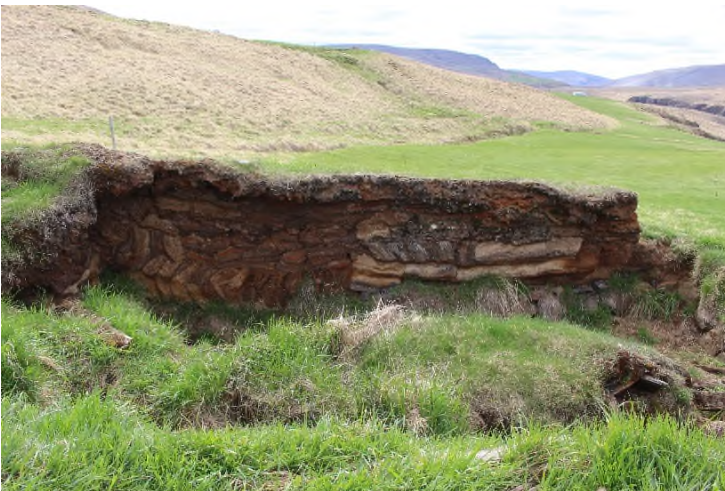
Mynd 58. Á efri mynd eru Pálshúsir í september 2021. Húsin eru að mestu tilbúin en það vantar enn hurð og glugga. Á neðri mynd er suðurveggur fjárhúsanna fyrir viðgerð. Veggurinn er margviðgerður eins og sést og má bæði sjá klömbruhnaus án strengjar og hnausa af öllum stærðum og gerðum.
