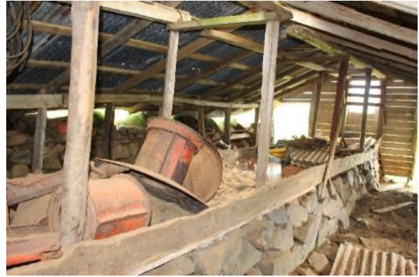
Mynd 18. Myndin til vinstri er tekin inn nyrðri króna í fjárhúsunum á Bjarnastöðum. Til vinstri á mynd er veggur úr grjóti í streng. Líklegt verður að teljast að torf hafi verið ofan á grjóthleðslunni eins og er innst í krónni. Grjóthlaðinn garði er til hægri og á honum standa stoðir. Gólfíð er flórað. Á hægri myndinni er horft yfir garðann og sér í stoðir útundir vegg í syðri krónni og timburpilið. Blandað sperru- og ásaþak er í húsunum, bárujárnsklætt.
