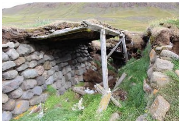
Mynd 115. Til vinstri er horft ofan í hlöðuna. Veggir eru að mestu hlaðnir úr grjóti í streng en efst sést m.a. í klömbruhnaus með streng á milli. Til hægri er horft inn í nyrðri húsin. Það sem sést af norðurvegg er alfarið hlaðið úr grjóti í streng. Meirihluti þaksins er fallinn en húsin stóðu vel fram yfir 1991 og voru í notkun fram á þessa öld.
