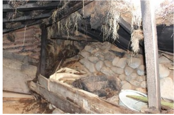
Mynd 39. Á vinstri mynd er horft á norðurvegg gamla hesthússins, sem hlaðinn er úr klömbruhnaus án strengjar. Auka stoð hefur verið bætt þarna inn til að halda við þakið. Til hægri er horft til suðausturhorns hússins og má sjá stallinn neðst en ás og rafta efst á mynd. Veggurinn er þarna hlaðinn úr grjóti í streng. Á báðum myndum sést glögglega hve grindin er orðin sviðin eftir reyking.
