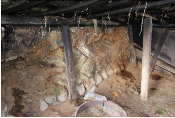
Mynd 39. Á vinstri mynd er horft á norðurvegg gamla hesthússins, sem hlaðinn er úr klömbruhnaus án strengjar. Auka stoð hefur verið bætt þarna inn til að halda við þakið. Til hægri er horft til suðausturhorns hússins og má sjá stallinn neðst en ás og rafta efst á mynd. Veggurinn er þarna hlaðinn úr grjóti í streng. Á báðum myndum sést glögglega hve grindin er orðin sviðin eftir reyking.
