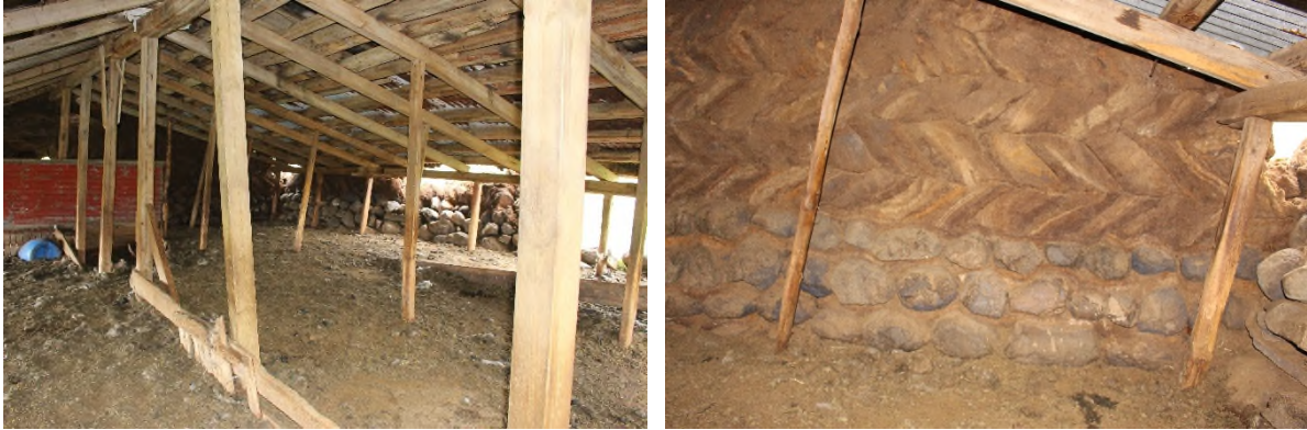
Mynd 93. Á vinstri mynd er horft inn fjárhúsin á Þorsteinsstaðakoti. Neðst sést í garðaböndin og stoðirnar. Til hægri á myndinni sér í grjóthleðslur í suðurvegg. Myndin til hægri er af austurgafli húsanna. Neðst eru þrjár raðir af grjóti í streng en ofar er klömbruhleðsla án strengjar.
