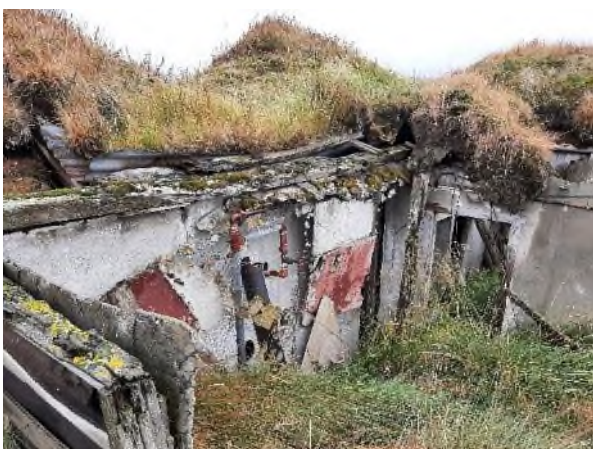
Mynd 98. Til vinstri er horft ofan í eldhúsið sem var múrhuðað (forskalað) að innan. Á suðurveggnum sést í vatnsleiðslur en kolaeldavél stóð við þennan vegg. Til hægri eru dyrnar út á ganginn. Hægra megin við eldhúsið var baðstofan og vinstra megin var búrið. Á hægri mynd er horft ofan í ganginn og þar var rafmagnstaflan. Um vinstri dyrnar var gengið í eldhúsið en um þær hægri yfir í baðstofuna sem þá var notuð sem svefnherbergi.
