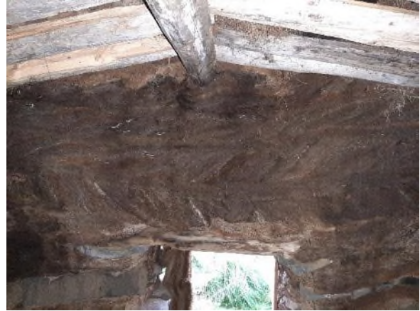
Mynd 122. Á vinstri mynd eru hlóðirnar í eldhúsinu en þær eru taldar vera frá því um aldamótin 1800. Hlóðirnar eru tvöfaldar eins og sést og er ein hella á milli þeirra sem stendur upp á rönd. Til hægri er norðausturveggurinn og á honum dyr. Ofan við dyrnar sést gömul torfhleðsla með klömbruhnaus í streng og alveg efst sést í enda mæniássins og rafta. Grind og þak eru nýlega viðgerð.
