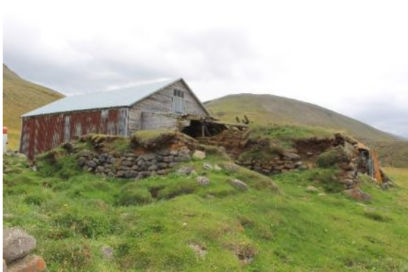
Mynd 109. Til vinstri er norðurendi gamla bæjarins, þ.e. fjósið og á bakvið það sést glitta í þil baðstofunnar og þak hesthússins. Til hægri er norður innveggur fjóssins. Neðst sex raðir af grjóti í streng og ofan við er torfhleðsla sem virðist helst blanda af þunnum aflöngum hnaus (sniddu) eða mjög þykkum streng í bland við mjórri streng.
