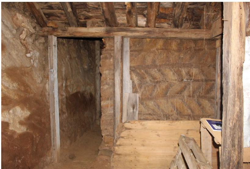
Mynd 53. Mynd tekin í holinu. Horft er inn göngin að baðstofu að hlóðaelldhúsinu. Lengst til hægri er gengið inní bú. Veggurinn fyrir miðri mynd er nýr en veggurinn til vinstri er gamall.
