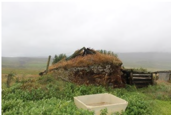
Mynd 97. Á vinstri mynd er suðurhlið bæjarins í Breiðargerði. Lengst til vinstri er framhúsið, þá svefnherbergi og síðan baðstofan til hægri. Á myndinni til hægri er austurgöfl baðstofunnar, hlaðinn að mestu úr torfi. Til hægri við baðstofuvegginn er eldhúsið.
