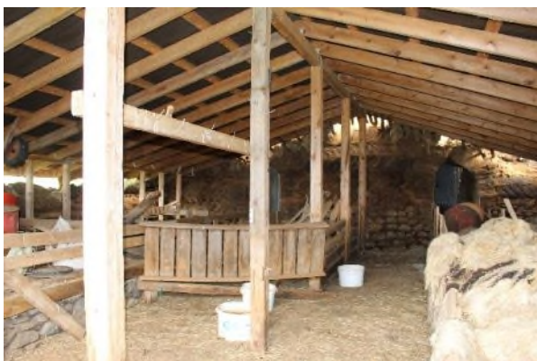
Mynd 15. Horft inn syðri fjárhúsin á Syðri-Brekkum. Þarna sjást vel sperrur í þakinu, stoðirnar og garðar til beggja handa. Á hægri myndinni sést í austurgaflinn. Á honum eru tvennar tóftardyr. Hann er vel hár og hlaðinn að mestu úr klömbruhnaus með streng á milli. Lengst til hægri má sjá tvær raðir af klömbrum sem snúa til sömu áttar.
