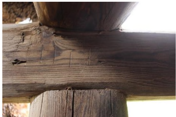
Mynd 104. Hleri var ofan í kjallarann í múrhuðaða herberginu og þar voru höfð smálömb allt fram til ársins 2012 samkvæmt heimildamanni (Munnleg heimild: Ylfa Leifsdóttir, 16.02.2022). Til hægri má sjá timbur merkt með fimm stuttum strikum en slíkt sést gjarnan í gömlum húsum. Ekki sjást nein merki á móti og því eru þetta hugsanlega spor eftir gamla merkingu.
