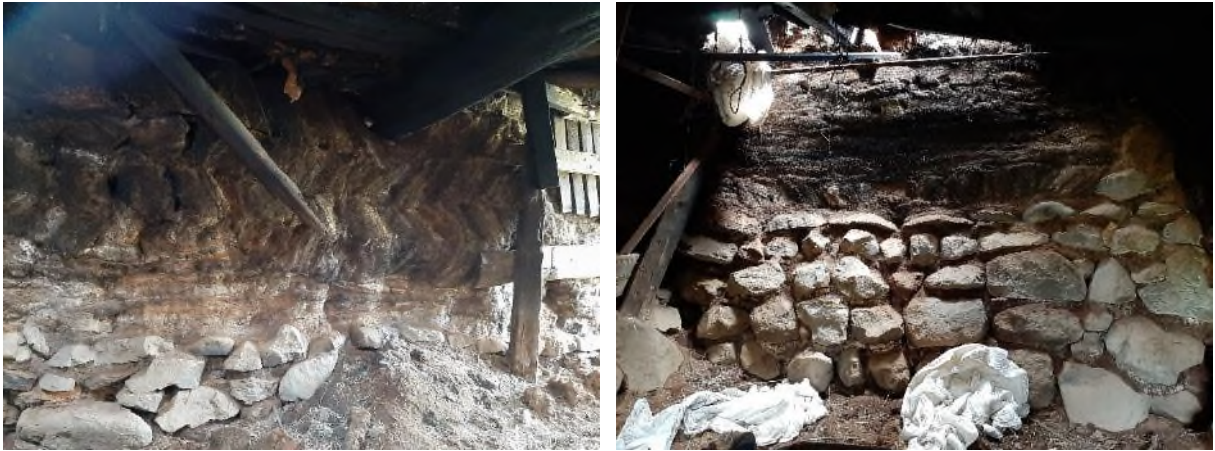
Mynd 46. Á vinstri mynd er suðurveggur gamla hesthússins. Ofan við grjóthleðsluna er strenghleðsla og ofar er klömbruhnaus án strengjar sem er að líkindum yngri en strengurinn (uppgilding). Á hægri mynd er austurveggur, hlaðinn úr grjóti í streng, síðan er ein röð af klömbruhnaus og þar ofan við strengur. Veggir í þessum húsum virðast fremur gamlir. Á hægri mynd sjá að torfið er sviðið eftir reykin.
