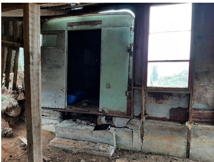
Mynd 76. Innst í fjárhúsinu/fjósinu hefur verið komið fyrir húsi af Mercedes bifreið og búið að steypa upp að því tröppu.
