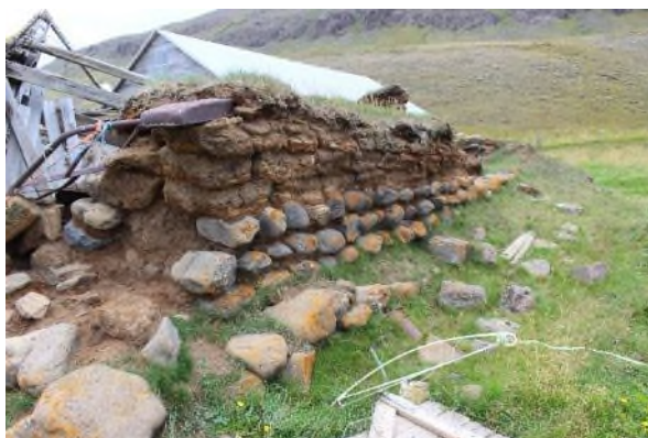
Mynd 108. Á mynd til vinstri sést í suðurhlið bæjarins. Neðsti hluti veggjar er hlaðinn úr grjóti í streng (þrjár raðir) en ofar er fremur stór hnaus, líkastur hornhnaus, notaður í allan vegginn. Á mynd til hægri er syðsti hluti bæjarins. Þar eru veggir hlaðnir úr grjóti í streng og sjást þrjár raðir af grjóti en ofar er hnaus.
