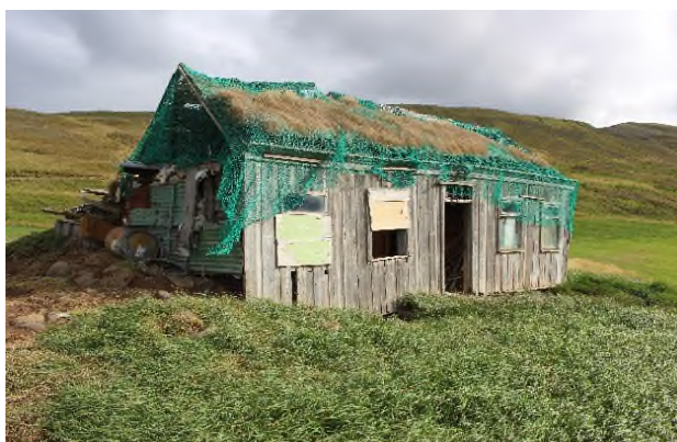
Mynd 5. Myndirnar sýna hús þar sem eigendur hafa gert ráðstafanir til þess að verja húsin. Á efstu mynd til vinstri er búið að hengja staur meðfram torfveggnum til að varna því að hestar nagi húsin. Á hægri myndinni hefur net verið sett yfir þakið til að varna foki og á neðstu myndinni hefur stoð verið skotið undir rafta til þess að styðja við þakið.
