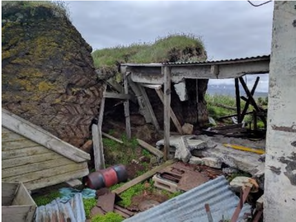
Mynd 128. Norðurhlið bæjarins. Á vinstri mynd sést í gafla sem hlaðnir eru úr klömbruhnaus með streng á milli. Á hægri mynd er norðurhluti framhússins sem er alveg fallinn nema þilið sem enn hangir uppi. Ljósmyndir: Guðmundur St. Sigurðarson.
