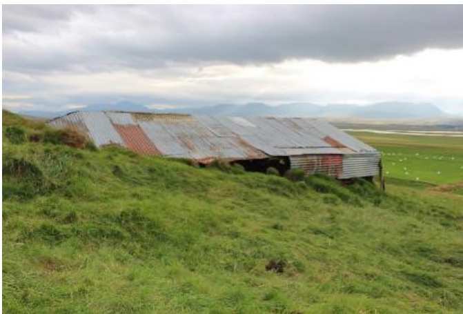
Mynd 16. Á efri mynd sést stafn fjárhúsanna á Bjarnastöðum (til austurs) og grjóthlaðinn veggur sem tilheyrir tóftum miðhúsanna. Á neðri mynd sést norðurhlið fjárhúsanna. Járn er á þaki og að hluta yfir norðurútvegg.
