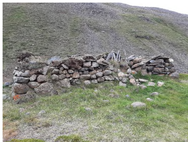
Mynd 130. Efri myndin er tekin á árunum 1940-1965. Þarna sést að lítill gluggi hefur verið í innra herberginu sem líklega var svefnaðstaðan. Smá stétt hefur verið við innganginn. Ljósmynd: Þjóðskjalasafn Íslands / Þorsteinn Jósefsson. Neðri myndin er tekin haustið 2021, þá er þakið og efri hluti veggja fallið.
