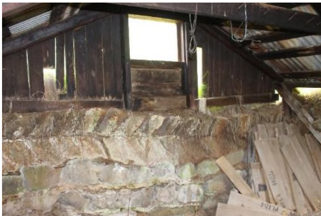
Mynd 90. Á vinstri mynd er austurveggurinn í reykkofanum. Hann er hlaðinn úr grjóti í streng neðst en klömbruhnaus með streng að ofan. Til hægri sést innan á framþil hússins sem er orðið nokkuð gisið.
