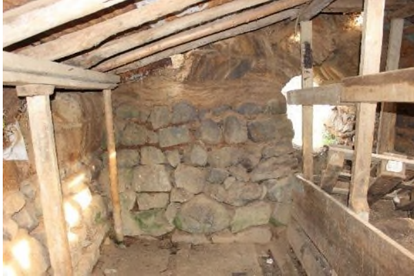
Mynd 14. Innst í nyrðri kró, nyrðri fjárhúsanna á Syðri-Brekkum. Húsin eru þríasa eins og sést á hægri mynd. Vaglar eru lagðir á milli hliðarása og kubbar (dvergar) ofan á þeim undir mæniásinn. Stoðir undir hliðarásnum standa á garðanum en stoðir undir syllum á gólfi. Til hægri er garðinn og við enda hans bogahlaðnar (samhlaðnar) dyr yfir í hlöðutóft. Fremur stórt grjót er í fjárhúsveggjum.
