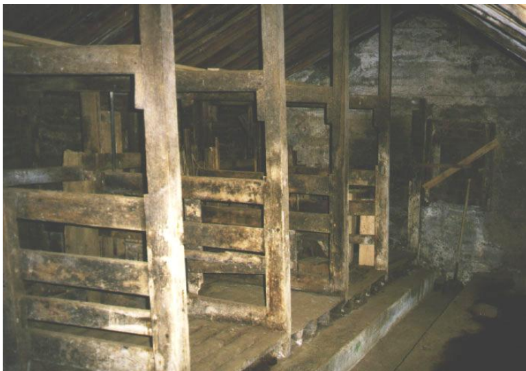
Fjósið að Bustarfelli í Vopnafirði er einsása hús. Bil milli stoða undir mænisás ákveða breidd básanna. Þéttleiki stoða byggðist á burðarþoli viðanna. Þak með grjóthellum og torfi er þungt. Flór er aftan við bása.
