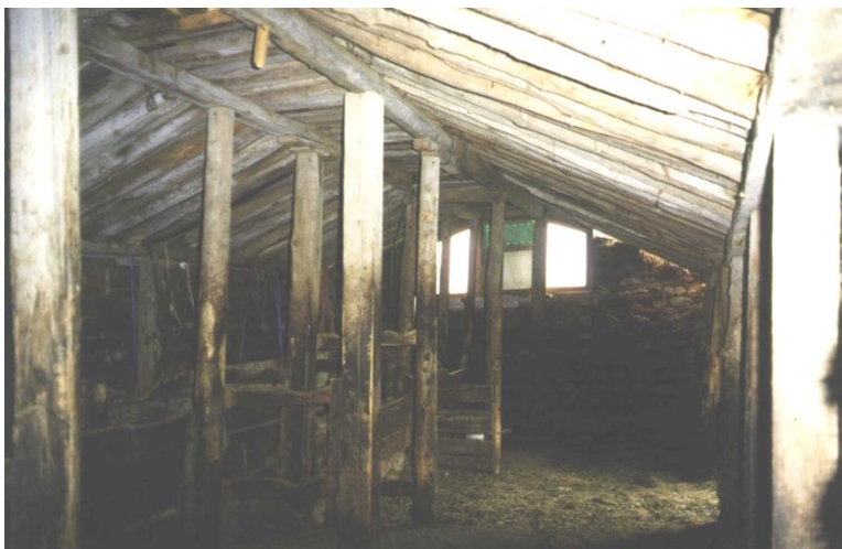
Tvíasahús, fjós á Syðri-Hofdölum sem síðast var notað sem hesthús. Stoðir standa undir ásum og syllum við vegg. Raftar eru lagðir frá veggjum (syllum) á ása. Stoðir undir ásum eru látnir stemma af bilið á milli bása.
