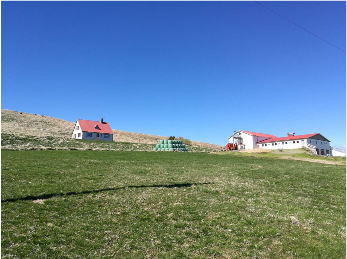
Mynd 1. Horft til vesturs upp að bæ og útihúsum á Eiðsstöðum. Gamli bærinn var hægra megin við núverandi íbúðarhús sem var byggt 1956.
