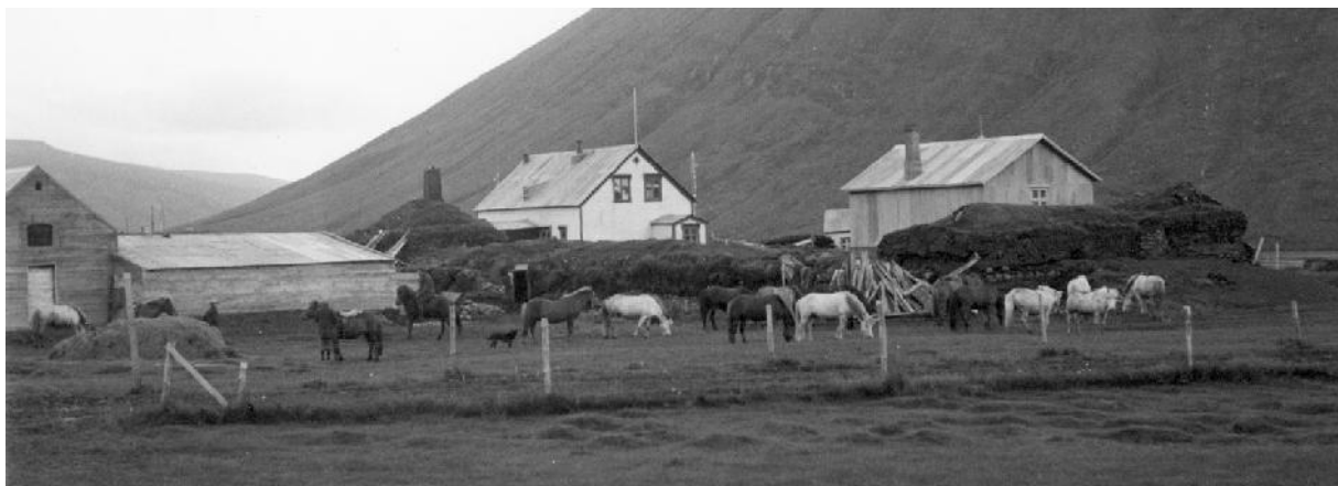
Mynd 3, Bólstaðarhlíð um miðjan fjórða áratug 20. aldar. Lengst til vinstri er steinsteypt hlaða sem enn stendur og fjárhús. Þar vestan við eru leifar útihúsa (nr. 10) sem voru áföst gamla torfbænum (nr. 2). Lengst til vinstri er hlóðaeldhúsið frá gamla bænum sem tengt var með viðbyggingu við íbúðarhús úr timbri sem reist var árið 1892 (nr. 1) og timburhúsið hægra megin við það er Þinghúsið (byggt á árunum 1924-28) hálf í hvarfi bak við hluta gamla torfbæjarins, líklega skemmuna (nr. 7). (Mynd: Bruno Schweizer, brot úr mynd BS 579. Tímatákn ehf.).
