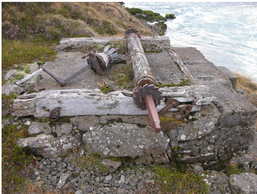
Mynd 12. Steyptur stöpull Flatatungukláfsins.
