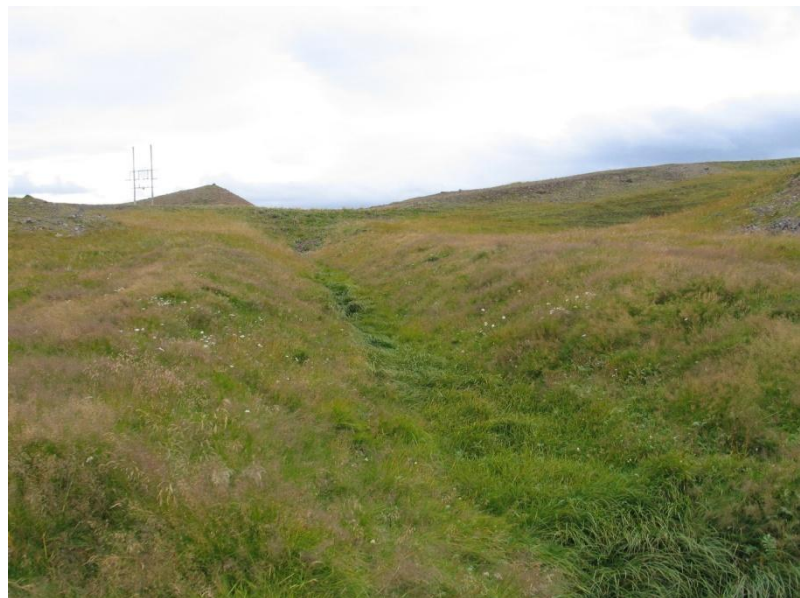
Mynd 16. Horft til norðurs eftir Tíðaskarðsskurði.
