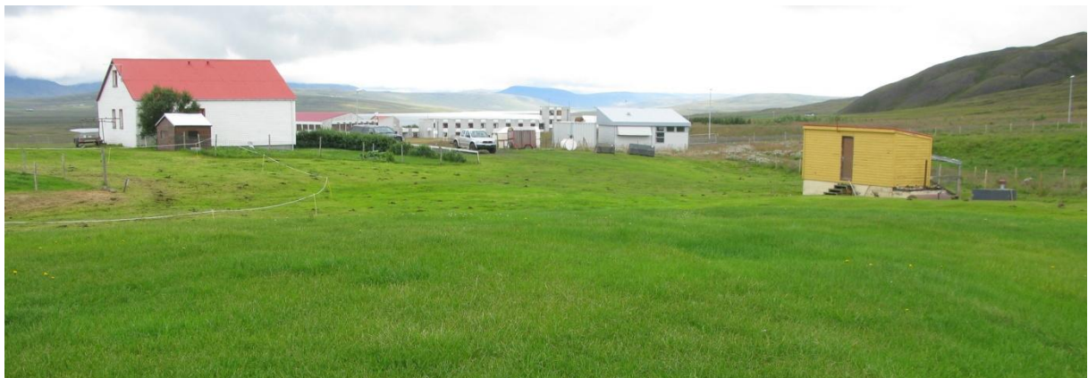
Mynd 40, horft til austurs, íbúðarhúsið á Reykjum til vinstri og Húnavallaskóli fjær fyrir miðri mynd. Samkvæmt túnakorti frá 1920 stóðu fjánhús(nr. 7) og matjurtagarður (nr. 6) á þessum slóðum.
