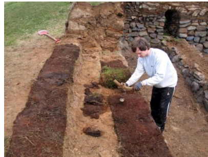
Strengur snyrtur til með torfljá
