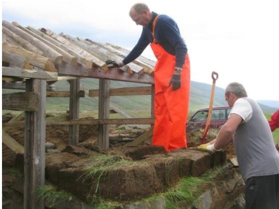
Mynd 5. Grindin komin í hlöðuna og nú á bara eftir að klára torfveggina sem hlaðnir eru úr hnaus.
