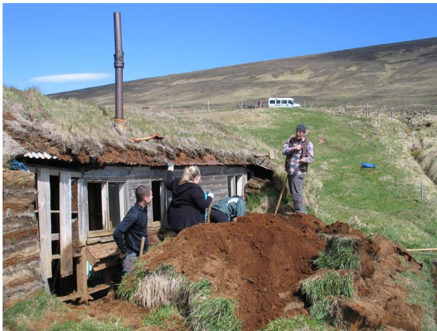
Mynd 3. Hópurinn að störfum – verið er að fjarlægja ónýtan torfvegg sem er endurnýttur við hleðslu nýs veggjar.
