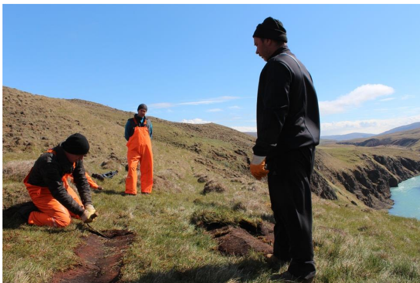
Mynd 4. Helgi Sigurðsson (til hægri) frá Fornverki ehf. sá um kennslu á námskeiðinu og leiðbeinir hér við torfskurð með ljá. Ljósmynd Sian Loftus.
