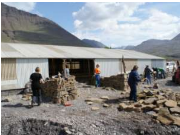
Mynd 9. Byrjað var á því að hlaða veggina sem mynda innganginn í húsið og síðan meðfram húsinu til suðurs. Ljósmynd: Guðmundur St. Sigurðarson.
