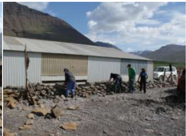
Mynd 10. Veggur var hlaðinn frá innganginum og meðfram húsinu. Ljósmynd: Guðmundur St. Sigurðarson.
