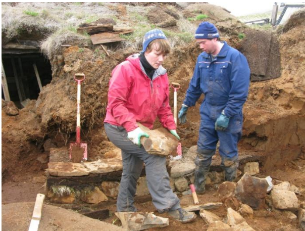
Mynd 9. Grjót valið í vegghleðslu.
