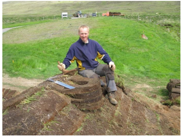
Mynd 12. Torf komið á þak og strompurinn tilbúinn.
