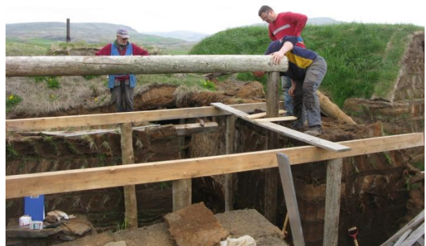
Mynd 14. Ásinn settur á sinn stað.
