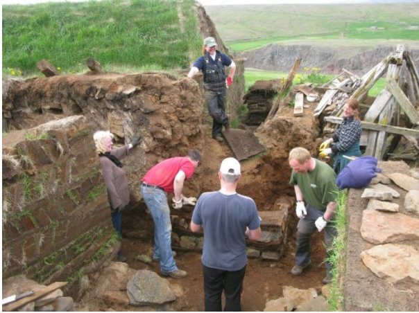
Mynd 11. Hornveggur hlaðinn, grjót og strengur á milli.
