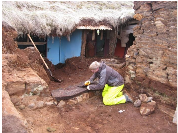
Mynd 8. Strengir skornir saman á neðstu röð grjóthleðslu í suðurvegg búrs.
