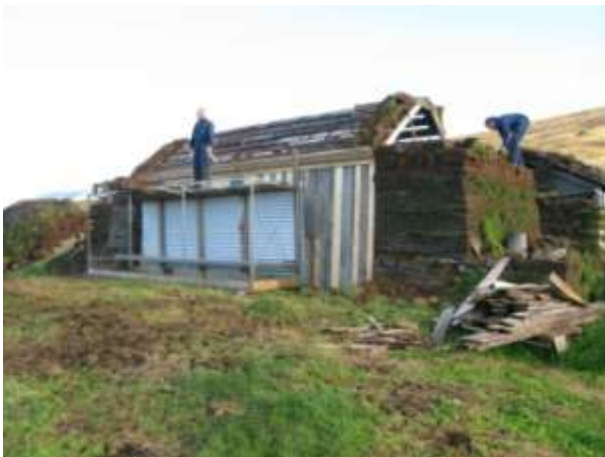
Starfsmenn Fornverks ehf. vinna að því að hlaða suðurgöfl og setja torfur á þakið.
