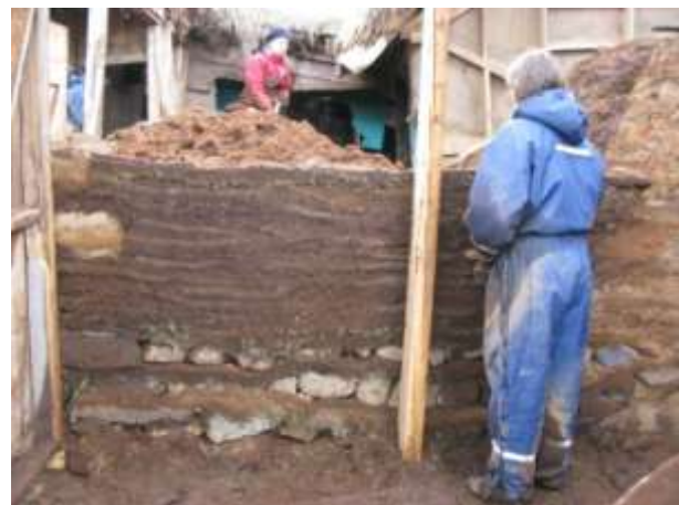
Fyllt er upp í veggina með mold til að jafna áður en annað lag er sett af streng
