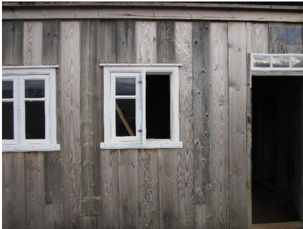
Mynd 1. Nýir gluggar voru settir í frambæinn í október 2011. Þeir voru smíðaðir af Braga Skúlasyni húsasmíðameistara. Í október 2013 voru gluggarnir kláraðir en þá var bætt við opnanlegum fögum.
