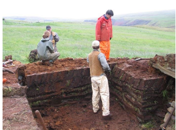
Mynd 8. Viðgerð á hlöðuveggjum hafin og á myndinni má sjá suður og vesturvegg að innan.
