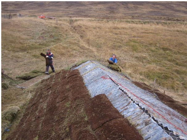
Mynd 11. Starfsmenn Fornverks ehf. setja nærpakið á baðstofuna.
