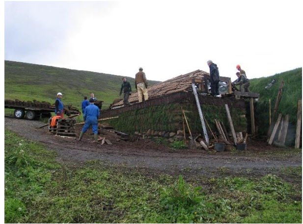
Mynd 6. Grindin er tilbúin og verið að leggja lokahönd við árefti og frágang á gluggum.
