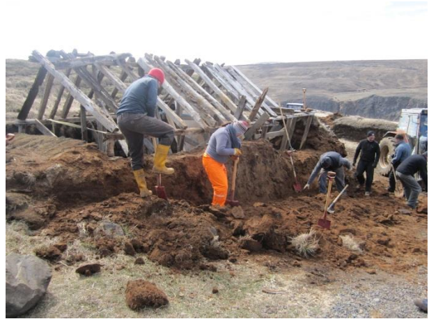
Mynd 4. Allt á fullu. Þarna eru nemendur að taka norðurvegginn niður en með því má lesa úr því hvernig hann var uppbyggður.
