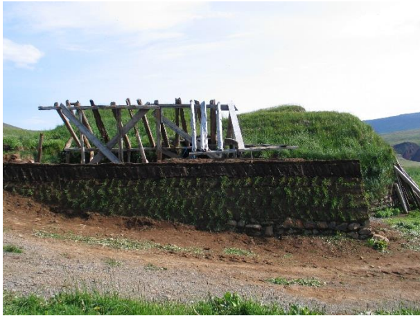
Mynd 5. Norðurveggur farinn að taka á sig mynd en aðeins á eftir að hlaða þarna eina röð af klömbru. Myndin er tekin áður en viðgerð á grind hófst.
