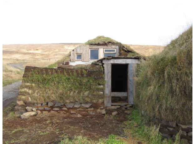
Mynd 2. Fjósíð á Tyrfingsstöðum eftir námskeiðin sumarið 2013. Þarna á eftir að ljúka við að setja efsta lagið af torfi framan við gluggana og ofan á bísalagið en það var gert af starfsmönnum Fornverks um miðjan október.
