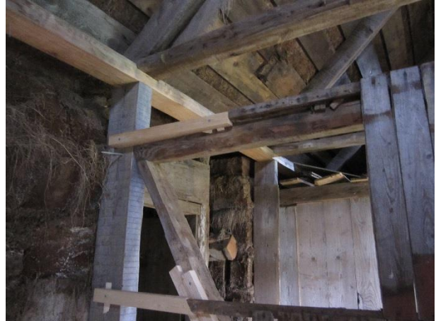
Mynd 10. Viðgerð á grind milliveggjar í stofu í framhúsi.
