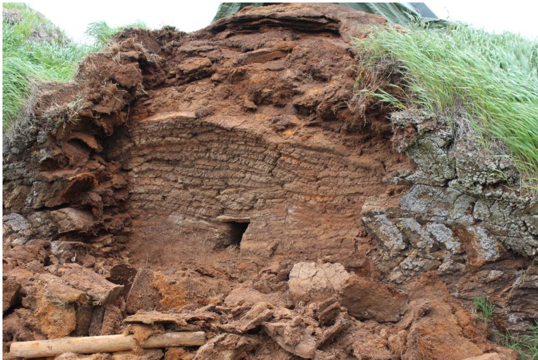
Gaflinn á skemmunni reyndist vera tvöfaldur og gamla 19. aldar gaflhlaðið blasti við þegar ytri veggurinn var fjarlægður. Til að varðveita gaflinn með sömu ummerkjum var sett á hann stag sem fest var við niðurgrafinn drumb.
