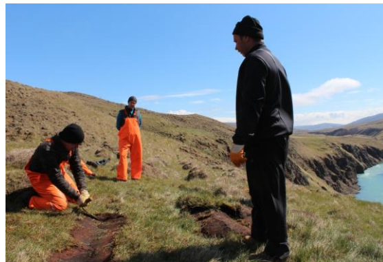
Á myndinni til vinstri er hópur nemenda frá Southern Connecticut State University að fjarlægja ónýtan torfvegg við suðurhlíð baðstofunnar á Tyrfingsstöðum 4. júní 2012. Á myndinni til hægri er Helgi Sigurðsson að leiðbeina nemendum um hvernig á að beita torfljá við torfskurðinn. Ljósmynd Sian Loftus.
