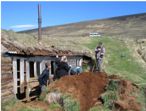
Á myndinni til vinstri er hópur nemenda frá Southern Connecticut State University að fjarlægja ónýtan torfvegg við suðurhlíð baðstofunnar á Tyrfingsstöðum 4. júní 2012. Á myndinni til hægri er Helgi Sigurðsson að leiðbeina nemendum um hvernig á að beita torfljá við torfskurðinn. Ljósmynd Sian Loftus.
