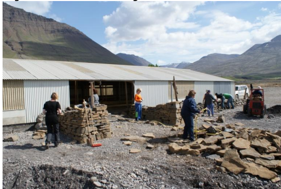
Byrjað var á því að hlaða veggina sem mynda innganginn í húsið og síðan meðfram húsinu til suðurs. Ljósmynd: Guðmundur St. Sigurðarson.
