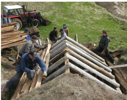
Grindin komin í búið fram á hlaði og þakið langt komið.
