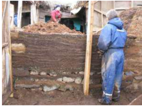
Á torfhleðslunámskeiði 2009. Páll Tryggvason setur streng í norðurvegginn. Fyllt er upp í veggina með mold til að jafna áður en annað lag er sett af streng.
