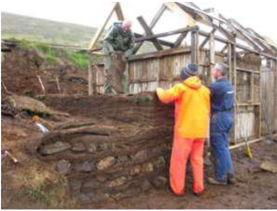
Á torfhleðslunámskeiði 2009. Páll Tryggvason setur streng í norðurvegginn. Fyllt er upp í veggina með mold til að jafna áður en annað lag er sett af streng.
