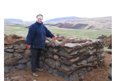
Guðný Zoëga við nýhlaðinn vegg á Tyrfingsstöðum
